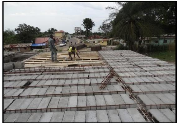
**Figure 92.** Plancher en corps creux
