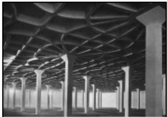
**Figure 93.** Plancher nervurée
