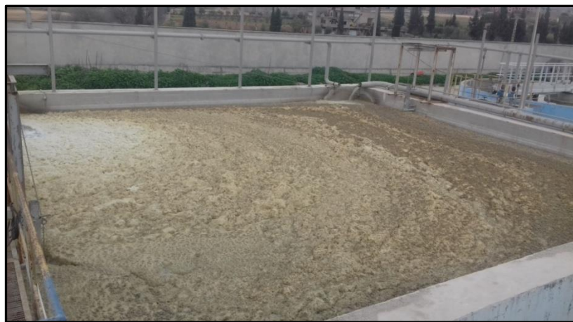
Photo. 20: Bassin de dénitrification (V10).
