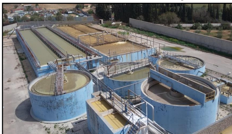
Photo. 12: La Station d'épuration de la Maïserie
