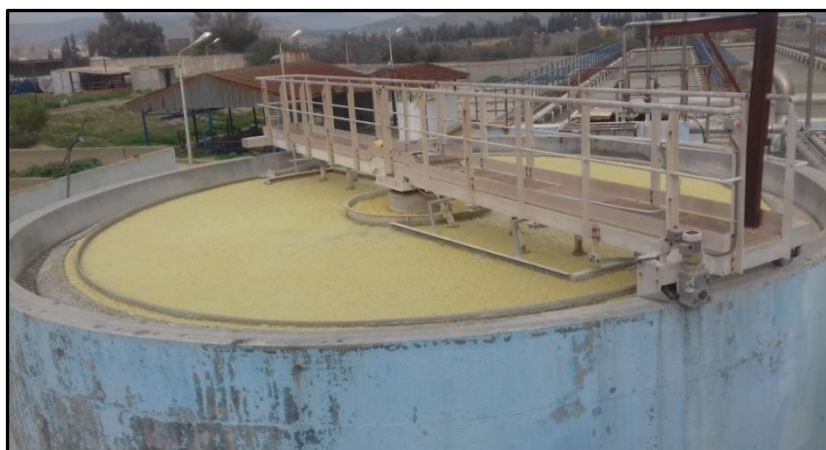
Photo. 17: Sédimentateur dynamique (V4).
