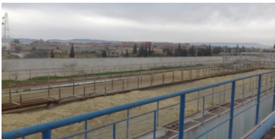
Photo. 21: Bassin d'oxydation biologique (V11).
