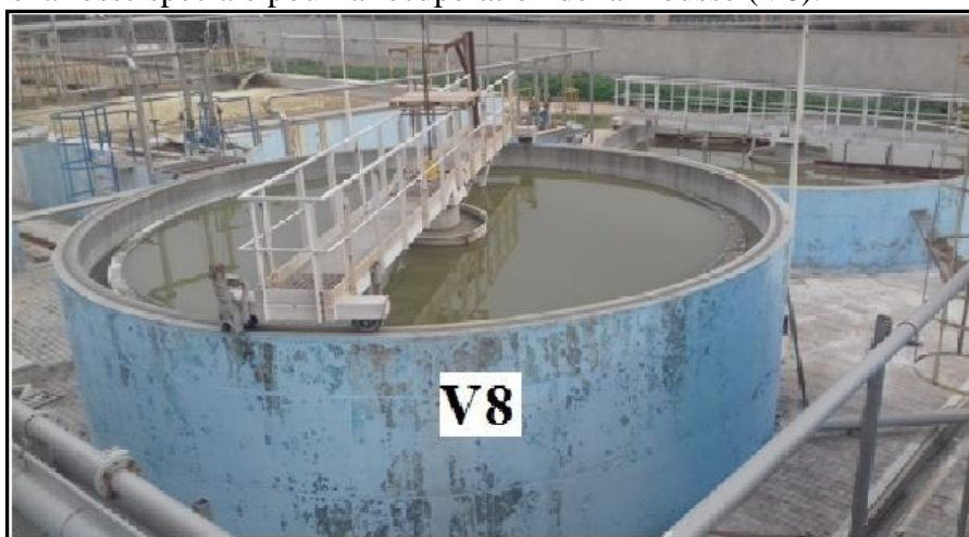
Photo. 19: Sédimenteur (V8).
