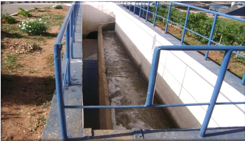
Figure II.9 : Le déversoir d'orage [30]
