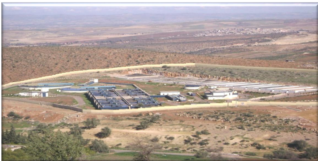
Figure II.8: Vue de la station d'épuration d'Ain El HOUTZ (Tlemcen) [29]
