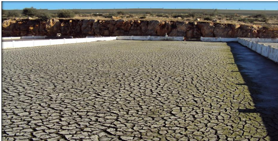
Figure II.18 : lits de séchage [28]
