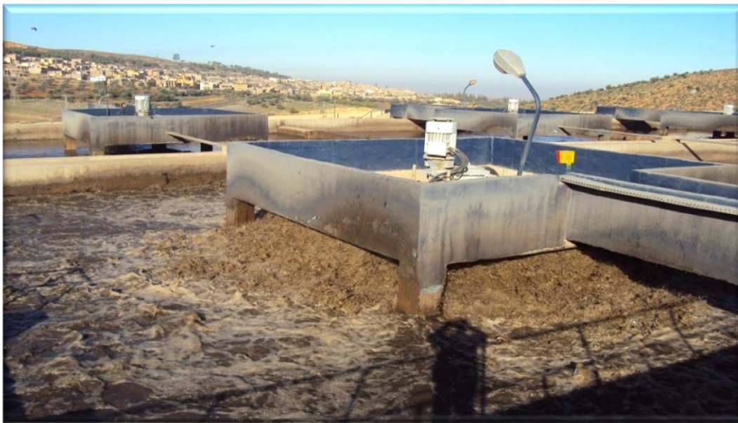
Figure II.14 : Bassin d'aération [30]
