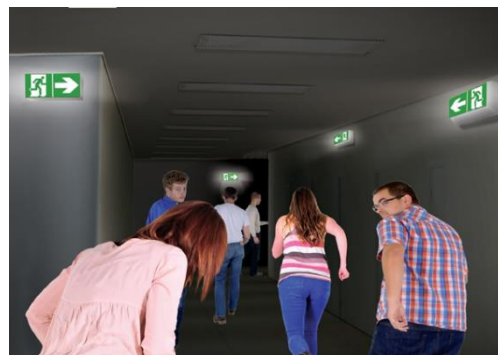
Figure 175 Panneau allumant permanente
