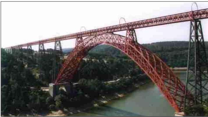
Figure 21 Le viaduc de Garabit
