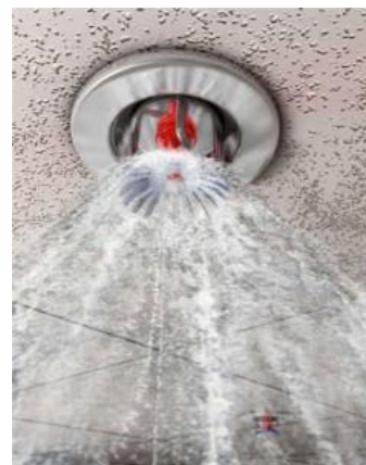
Figure 171 extincteur automatique
