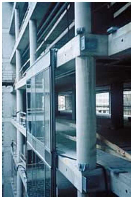
Figure 146 exemple de fixation mur rideau
