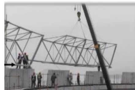
Figure 29 Méthode d'assemblage par blocs
