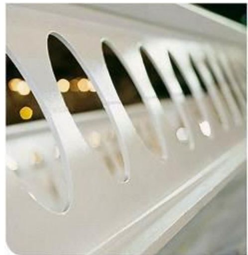
Figure 74 : schéma d'une poutre alvéolaire
