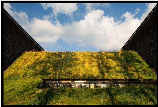
Protection contre les vents et le froid en hiver dans le côté nord par la terre végétalisée
