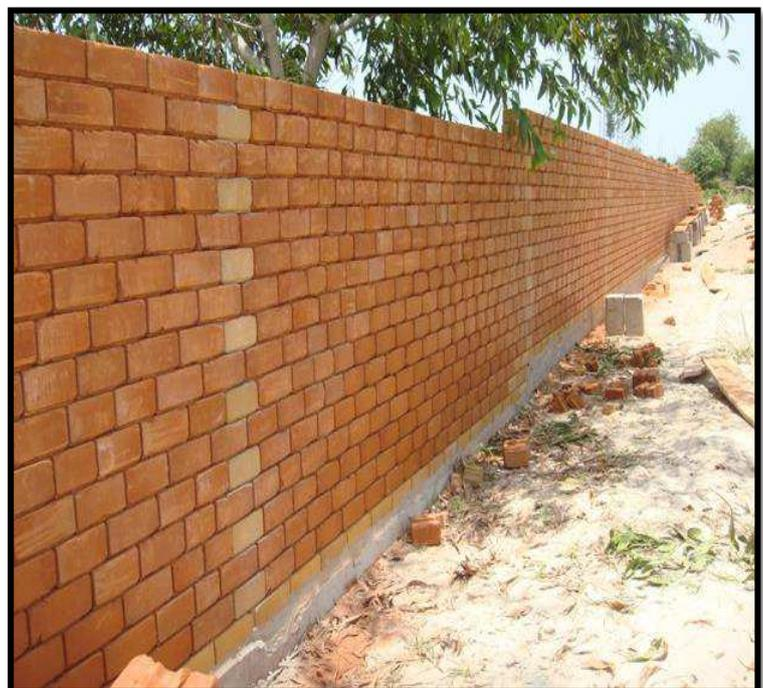
Figure 194. Un mur en brique de terre(BTCS)
