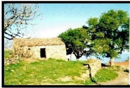
Figure 13: une maison kabyle .
