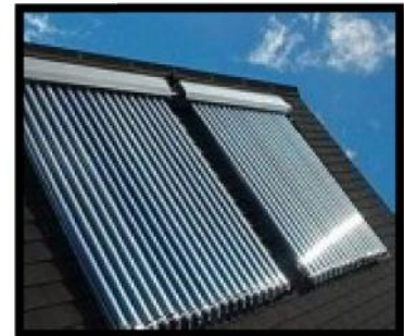
Figure 82 : l'emploi d'un panneaux solaires thermique .
