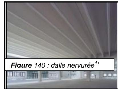
Figure 140 : dalle nervurée<sup>4+</sup>
