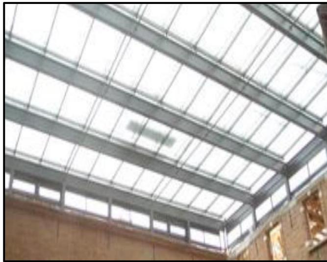
**Figure 149** : système de vitrage extérieur collé
