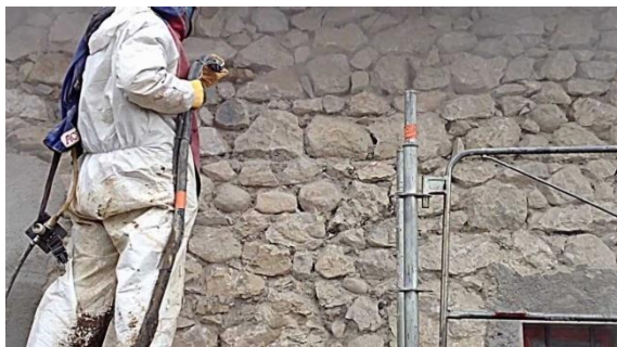
Figure 76: Travaux de sablage
