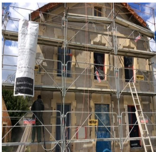
Figure 78: Travaux de restauration (Enduits)
