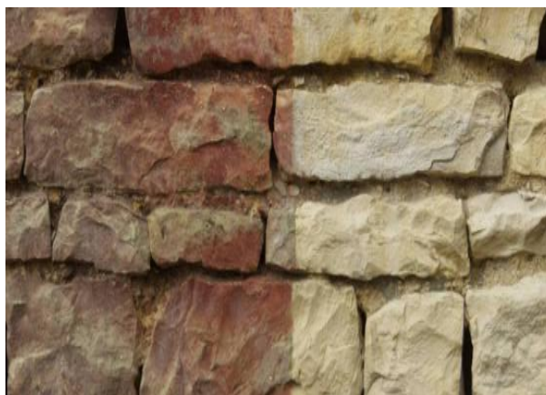
Figure 77: Mur en pierre avant et après sablage
