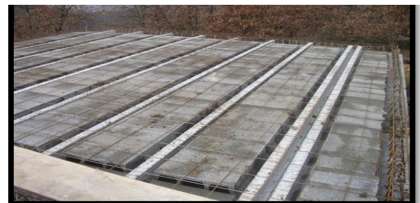
Figure 37 : Détails de coffrage avant coulage
