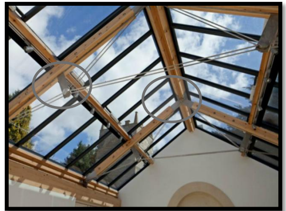
Figure 52: Pose de verrière sur charpente en bois
