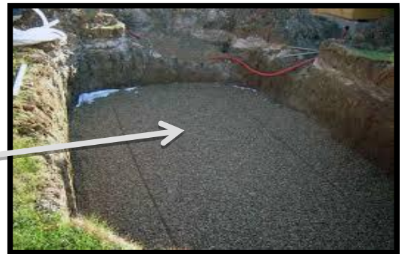
Figure 40: Exemple fouille grande masse pour sous-sol
