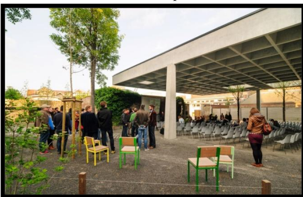
Figure 68 : Exemple de plancher a caisson (Ecole)
