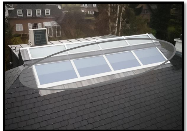
Figure 58 : Verrière posée sur toiture en ardoise
