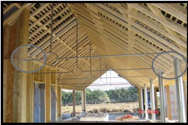
Figure 54: Pose de ferme en bois sur poteaux métalliques
