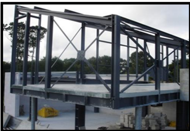
Figure 72 : Poutre métallique appuie sur poutre en béton
