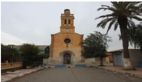
Figure 19 : Photo de la façade de l'Eglise
