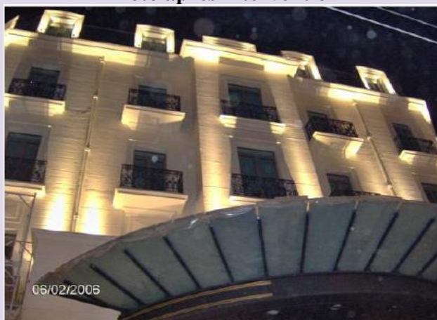
Photo après intervention
