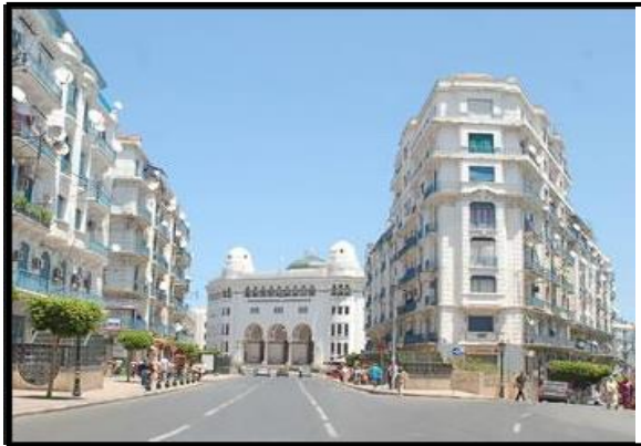
Figure 11: Réhabilitation immeubles Alger Source : http://www.lexpressiondz.com
