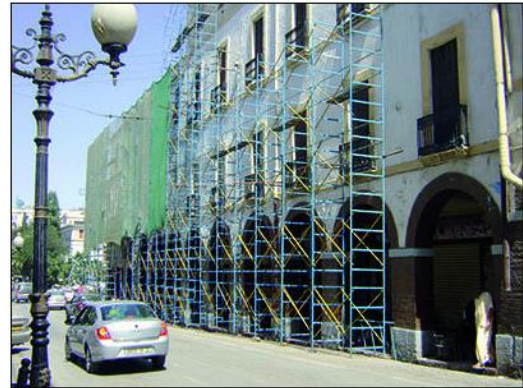
Figure 14: Réhabilitation immeubles Constantine Source : http://www.constantine-hier-aujourd'hui.fr
