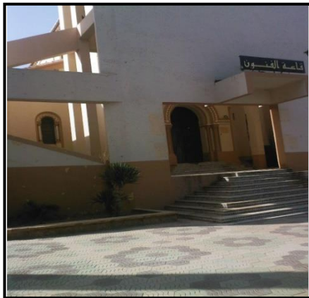
Figure 19 : L'ex Eglise Saint Michel à Tlemcen réhabilitée en galerie d'art Source : tlemcen.e-monsite.com
