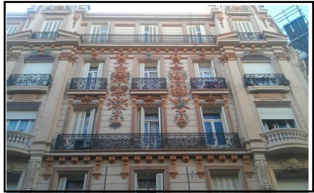
Figure 12: Réhabilitation immeubles Oran Source : http://forum.binyen.com
