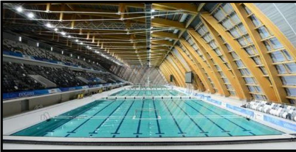
**Figure 180 : Structure en bois lamellé collé**
