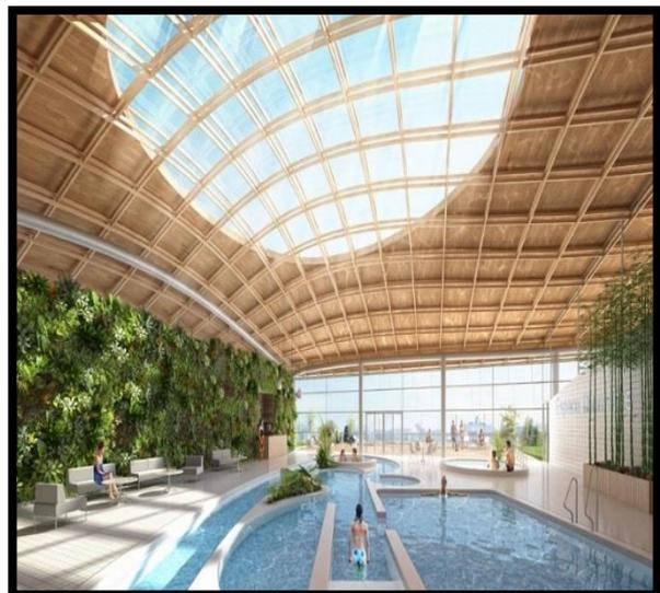
Figure 169 : Charpente en bois lamellé collé
