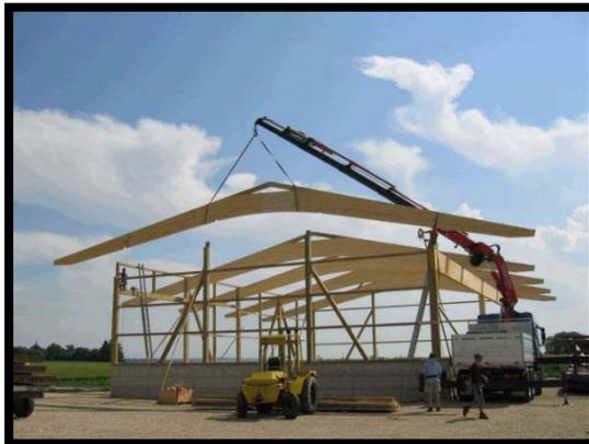
**Figure75** : Montage d'un bâtiment de stockage
