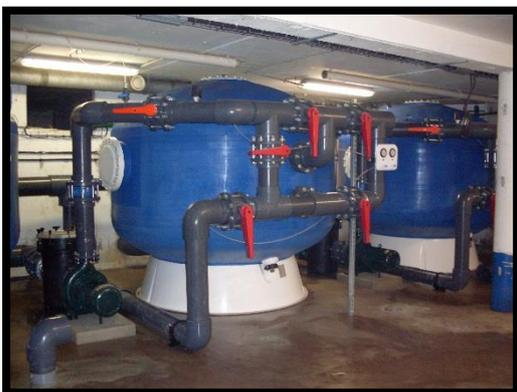
Figure 248 : les machines de filtration
