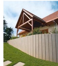
Figure 101 : Palissades en béton
