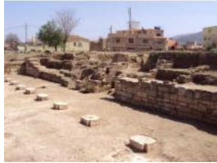
Figure 2 : L'oratoire de la mosquée d'Agadir, vue 1, lors des travaux d'aménagement en 2010. Vue sur le Mihrab.
