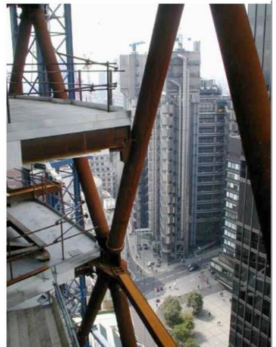
Figure 116 : Plaques de plancher jointes à Diagrid
