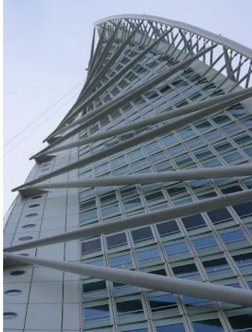
Figure 248 : façade de la tour recouverte de l'aluminium
