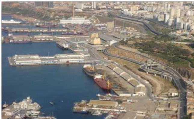
Figure 150 : Zone industrielle de Béthioua
