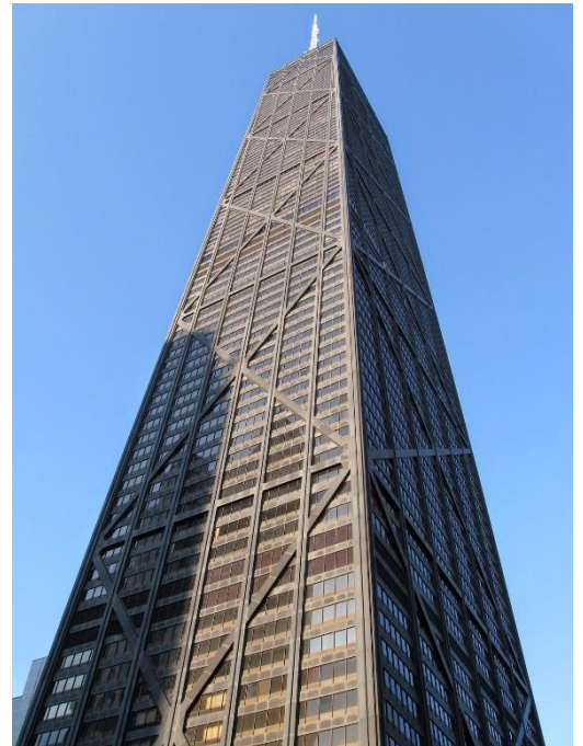
Figure 111 : Brace Tube Structure Bâtiment John Hancock, Chicago
