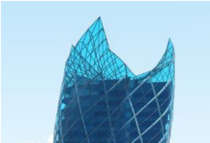
Figure 316 : détail de couronnement 'continuité de diagrid
