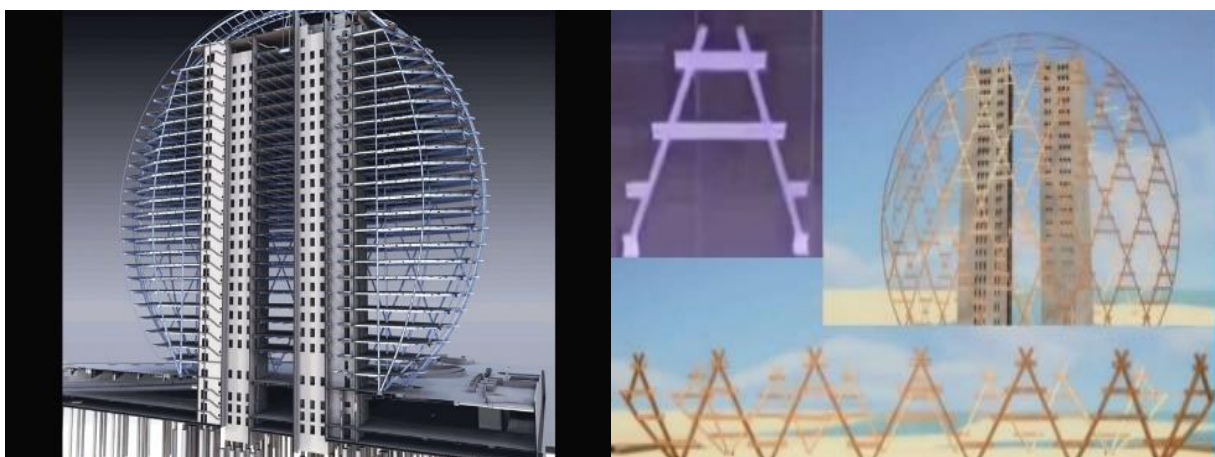
Figure 216 : la composition des 2 noyaux centrales avec le système porteur diagrid
