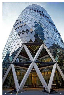
Figure 305 : système à double peau dans "THE GHERKIN"
