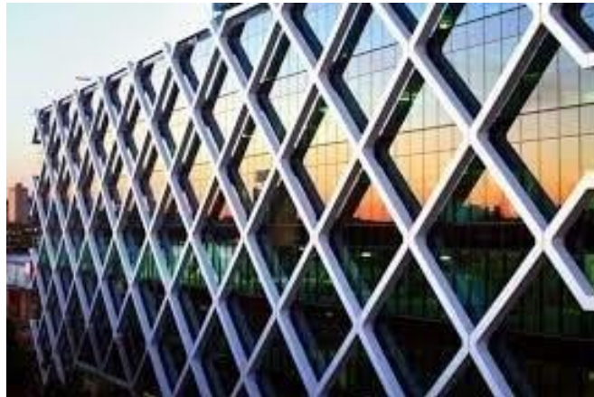
Figure 133 : façade d'un bâtiment avec un diagrid en acier
