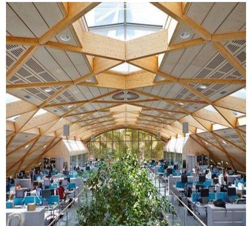
Figure 135 une couverture d'un immeuble avec un diagrid en bois
