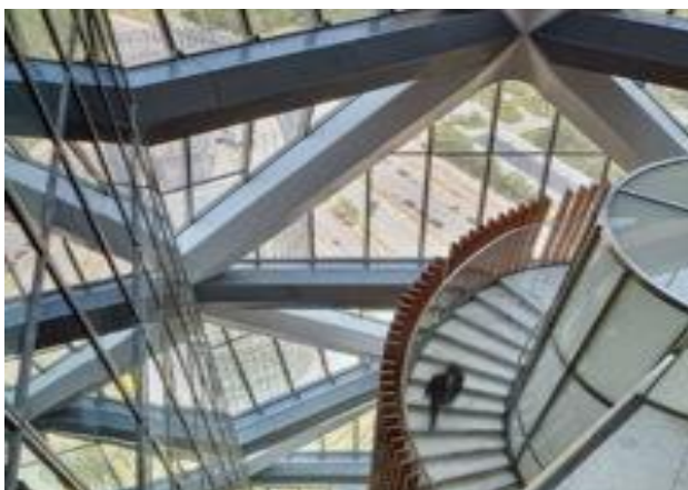
Figure 207 : la création des atriums pour la circulation verticale afin de donner une vue panoramique sur la façade
