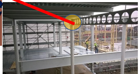
Figure 279 : la jonction entre les poteaux et les poutres
