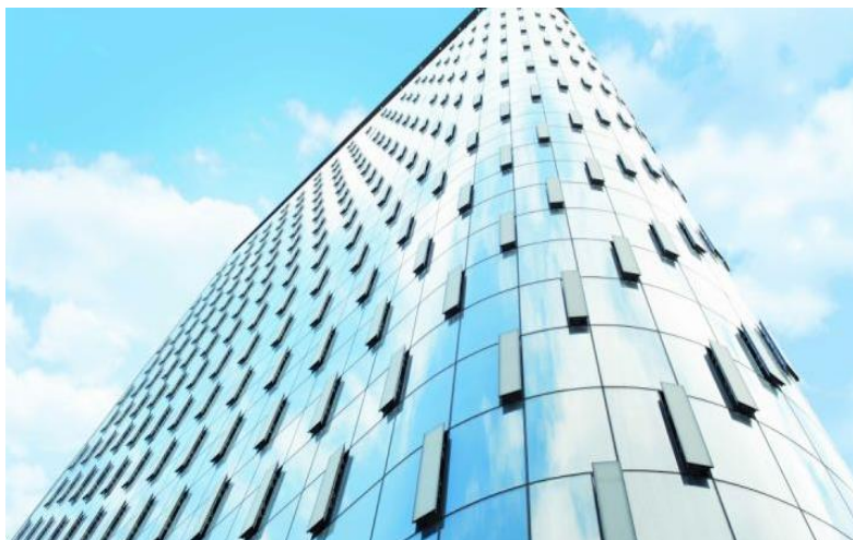
Figure 105 : les parois de verre de la tour Pittsburgh
