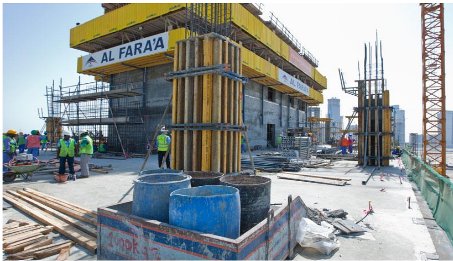
Figure 175 : Utilisation des méga colonnes afin de portée les dalles à grande porté
