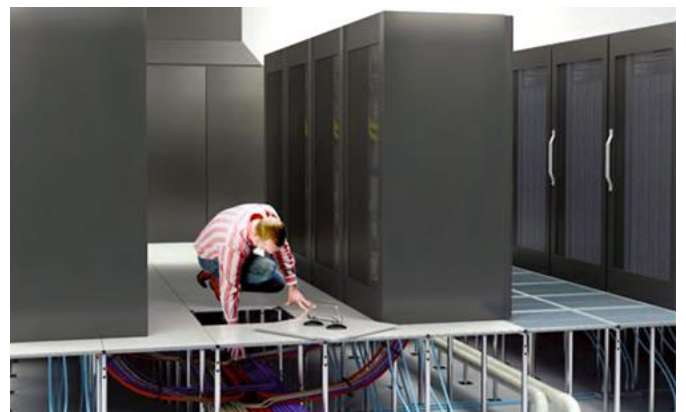
Figure 317 : Les planchers surélevés ont été conçus à l'origine pour équiper les salles informatiques
