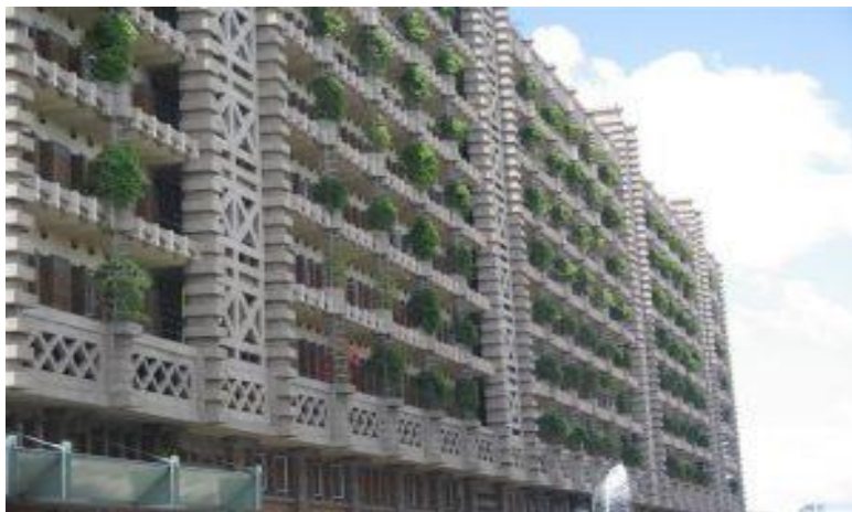
Figure 102 : Bâtiment Eastgate au Zimbabwe
