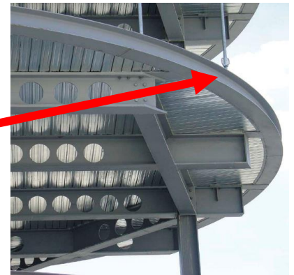
Figure 277 : la poutre circulaire utilisé dans les abords des poutres alvéolaire
