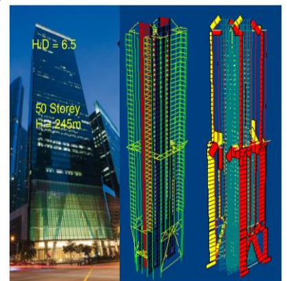
Figure 49 : la structure intérieure d'outrigger dans un bâtiment à Singapour
