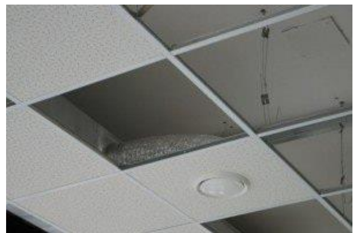
Figure 321 : revêtement d'un faux plafond
