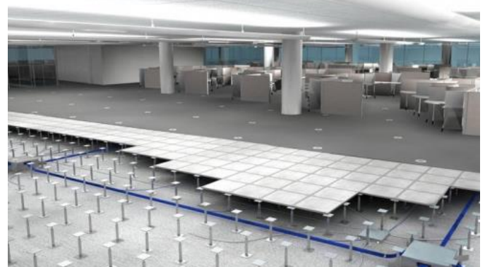
Figure 318 : installation des planchers technique sur les salles bureaux
