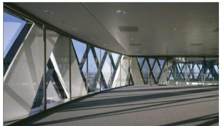
Figure 305 : système à double peau dans "THE GHERKIN"
