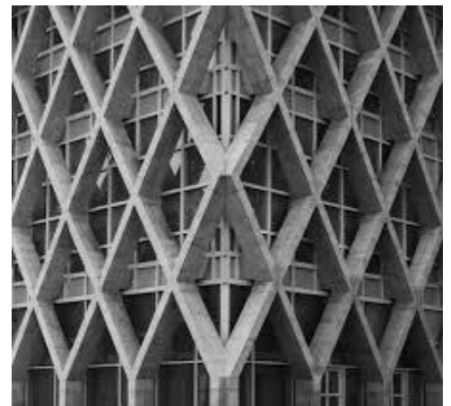
Figure 134 : façade de bâtiment IBM avec un diagrid en béton
