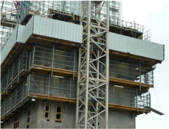
Figure 295 : le coffrage escalade D'Oka
