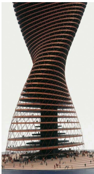
Figure 292 système structurelle noyau centrale
