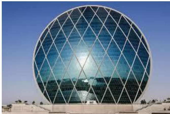
Figure 219 : la façade principale du projet d'Aldar
