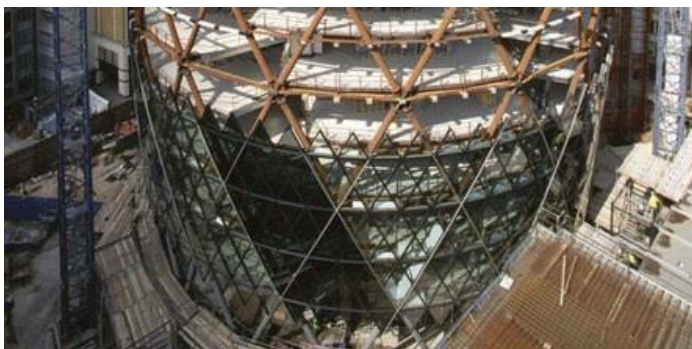
Figure 307 : double peau en métallique
