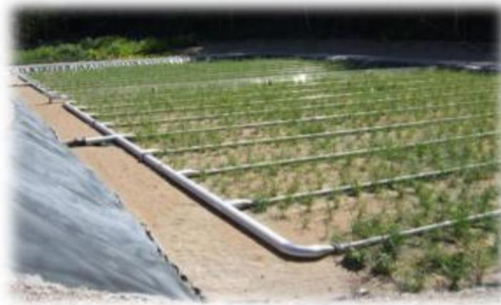
Figure 16 : Exemple de filtre planté de roseaux (14)
