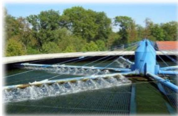
Figure 6 : Exemple d'une station à lit bactérien (10)
