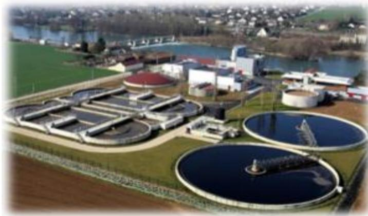
Figure 9 : Exemple d'une station par boues activées (13)
