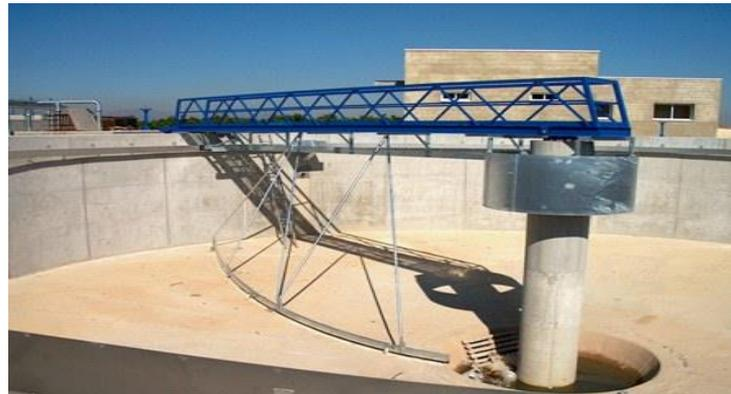
Figure 5 : Décanteur
