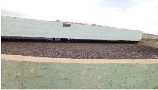
Figure 31 : Photo d'un épaisseur
