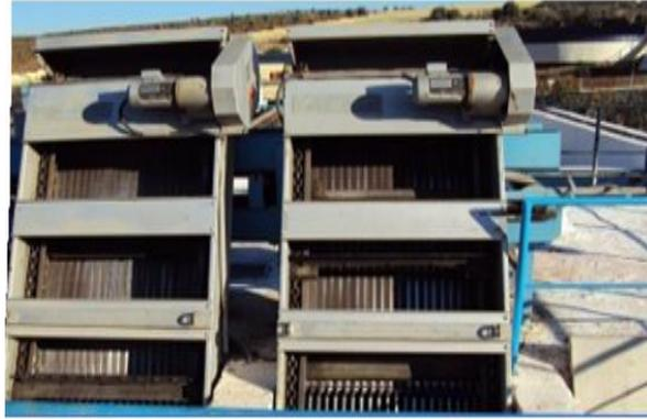
Figure 27 : Grille mécanisée
