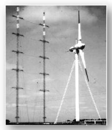
Figure I. 8: Growian, l'éolienne bipale downwind allemande de 3 MW [1].
