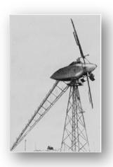
En Russie, afin de produire une puissance unitaire plus importante, ils arrivent à installer en 1930 une éolienne de 30m de diamètre à Balaklava (Crimée), construite par l'Institut Central de l'Énergie du Vent (ZAHI) de Moscou (*Figure I.5*), sa puissance nominale atteinte est 100 kW à une vitesse de vent de 10.5m/s [1] [44].
