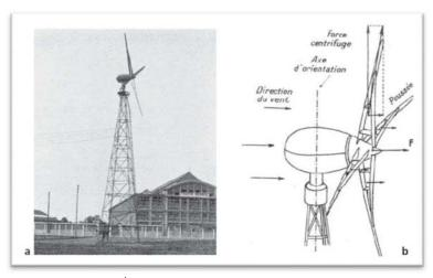
Figure I. 4: 1ère éolienne Darrieus avec rotor de 8 m [44].
