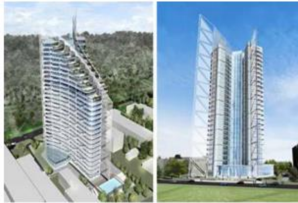
Figure VII.4 : Un nouveau d'hôtel à Sotchi, protégé par 156 isolateurs [8]
