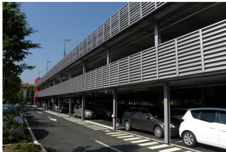
Figure I.3. Photo d'un parc de stationnement aérien multi-étages.
