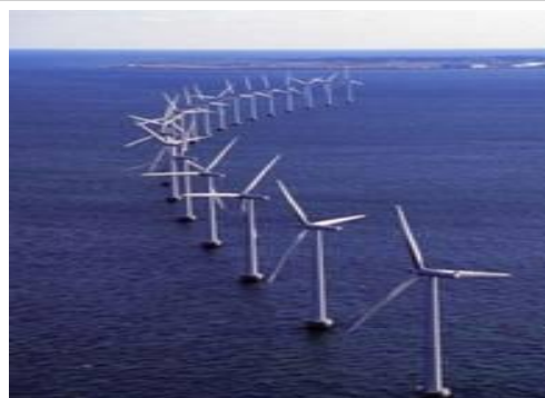
Figure I.6: Photographie d'une ferme éolienne offshore
