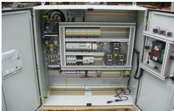
**Figure(III.23) : Coffret de découplage[15]**
