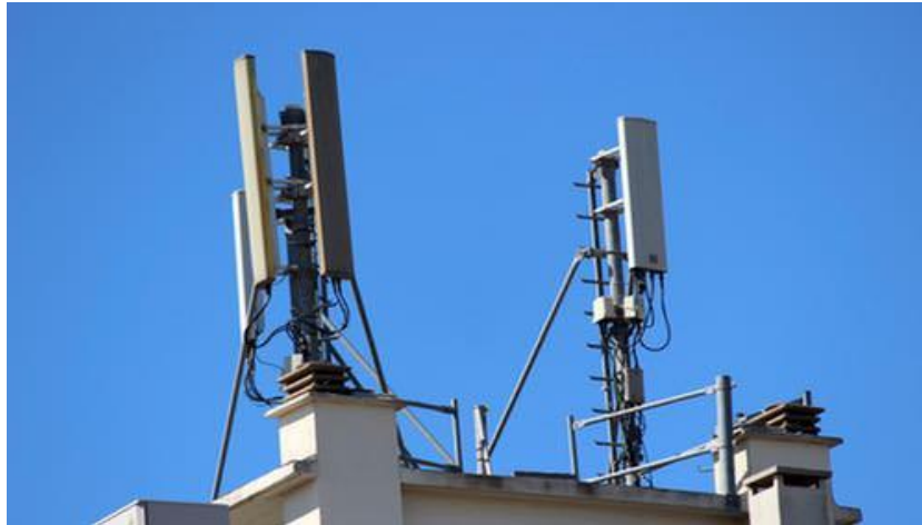
Figure1 : antenne-relais
