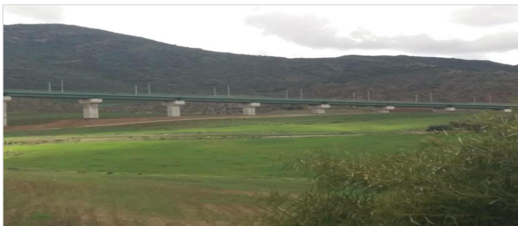
Figure II-2 : Le pont existant vue de loin
