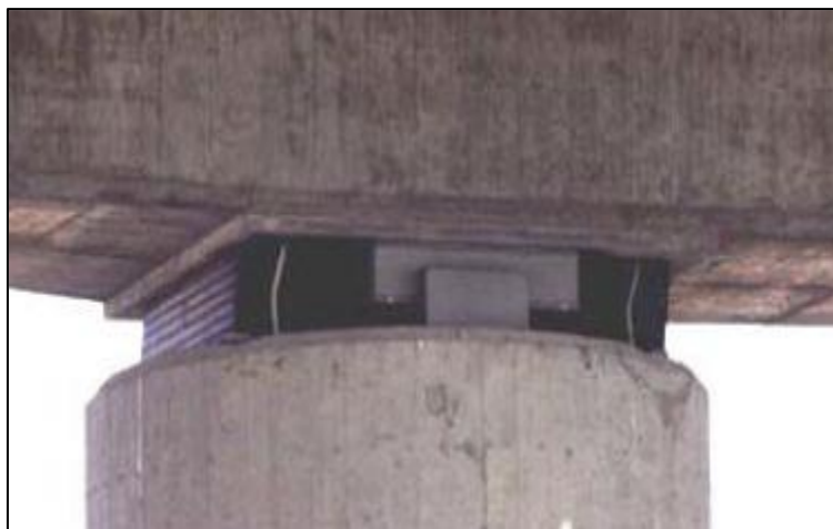
Figure VI-1 : photo réelle d'un appareil d'appuis
