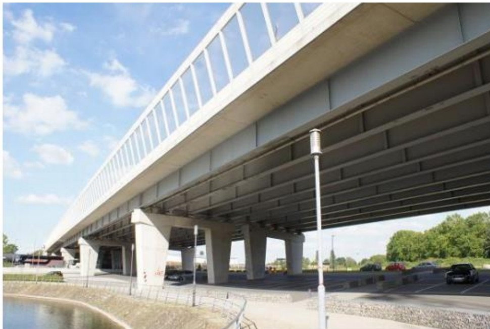
Figure I-3 : Vue d'un pont mixte acier-béton (autoroute A59, Allemagne)
