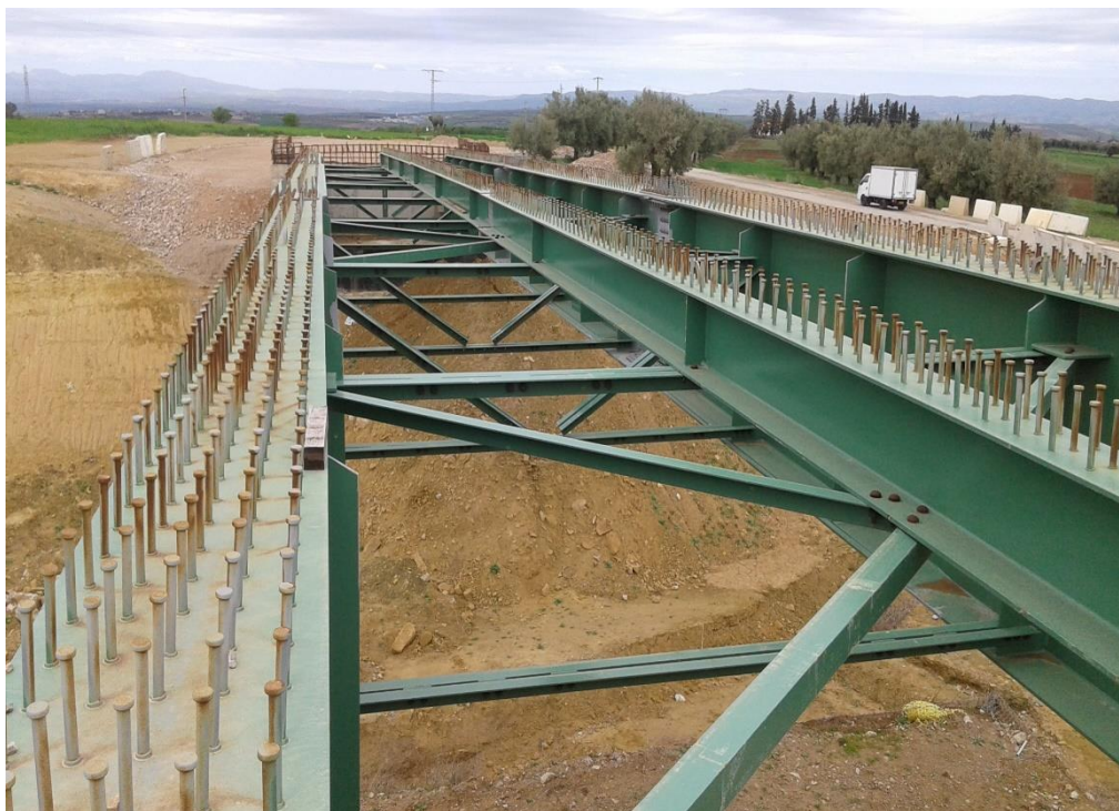
Figure I-14 : Connecteurs de type goujons
