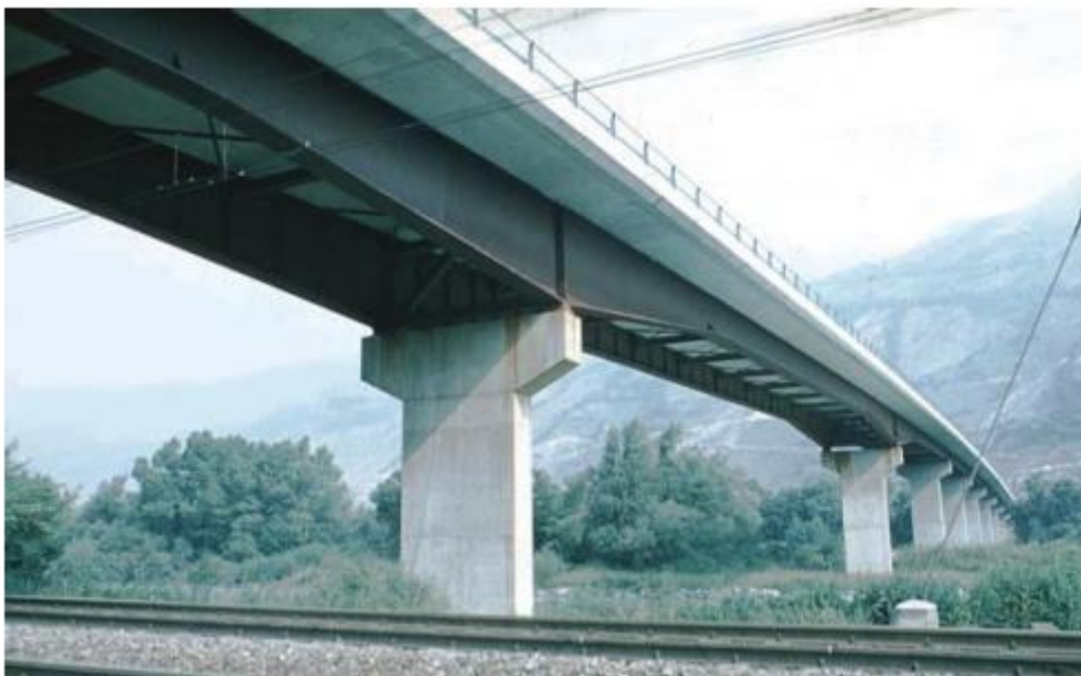
Figure I-7 : Exemple d'un pont mixte bipoutre
