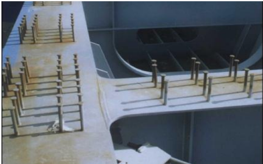
Figure V-11 : Connecteurs de type goujons
