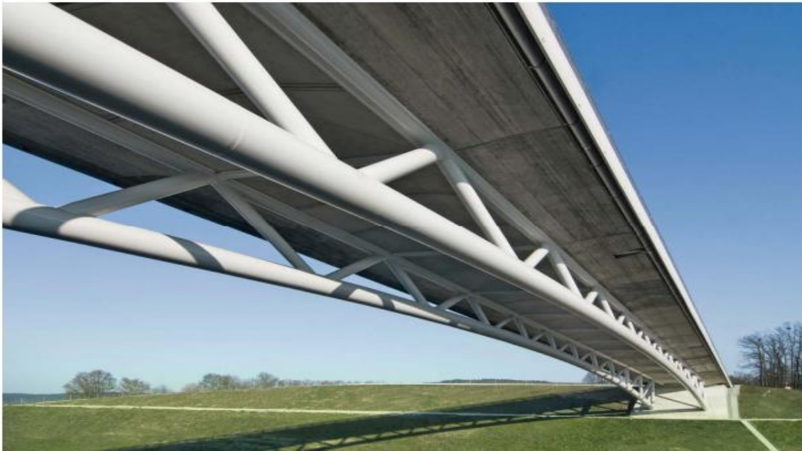
Figure I-4 : Pont mixte à culées intégrales par SSF, A73 (Munich), Allemagne
