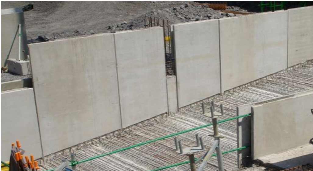
Figure1.1 : Mur voile en Béton Armé
