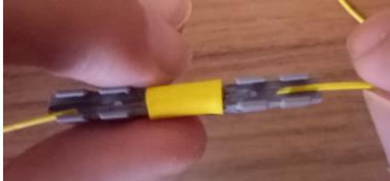
Figure III.34 : Etape « 3 » de l'épissure mécanique
