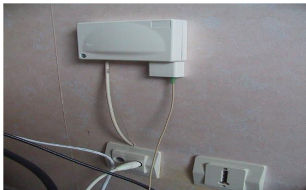
Figure IV.4 : Prise Terminal Optique.
