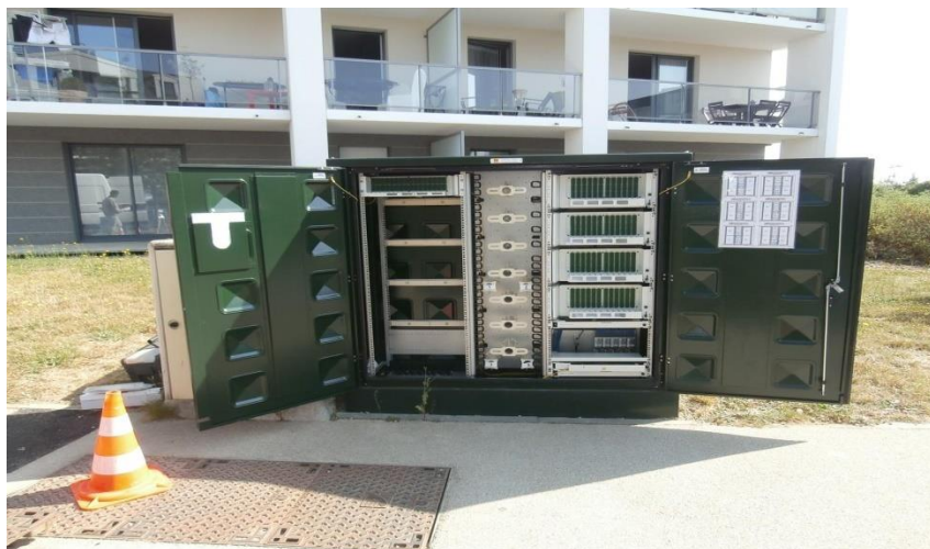
Figure IV.6: Sous Répartiteur Optique SRO.
