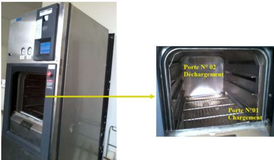
Figure 23 : l'autoclave de l'unité de stérilisation avec deux portes - fonctionnement en sas-
