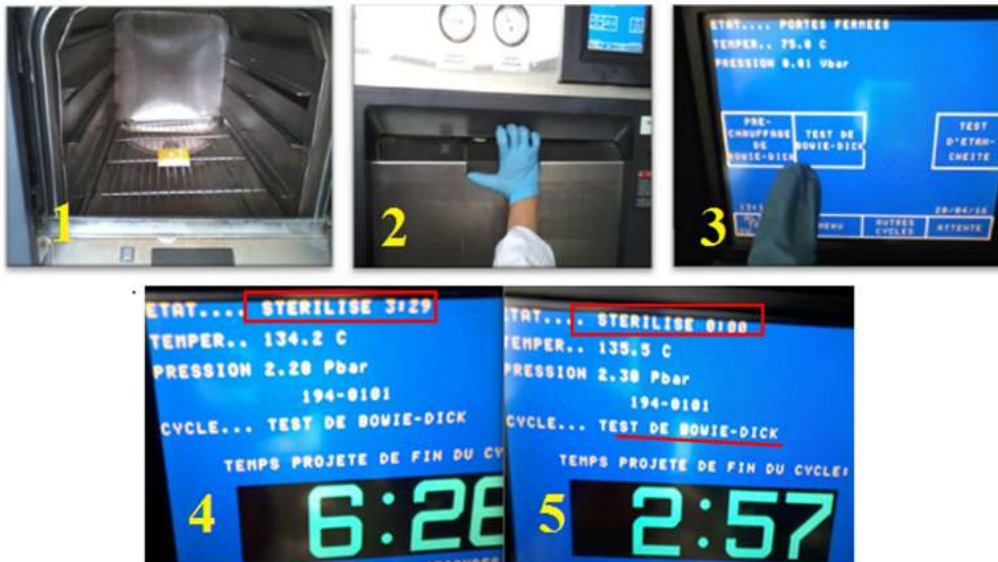
Figure 36: lancement du cycle de « TEST DE Bowie-Dick
