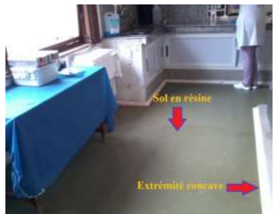
Figure 22 : Le revêtement en résine du sol de l'unité de stérilisation
