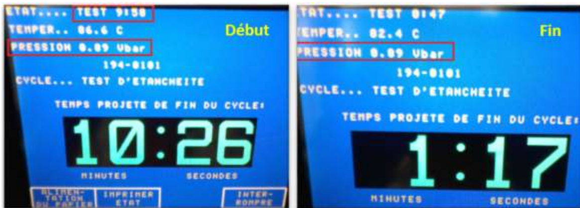
Figure 60: constance de la pression durant le test d'étanchéité
