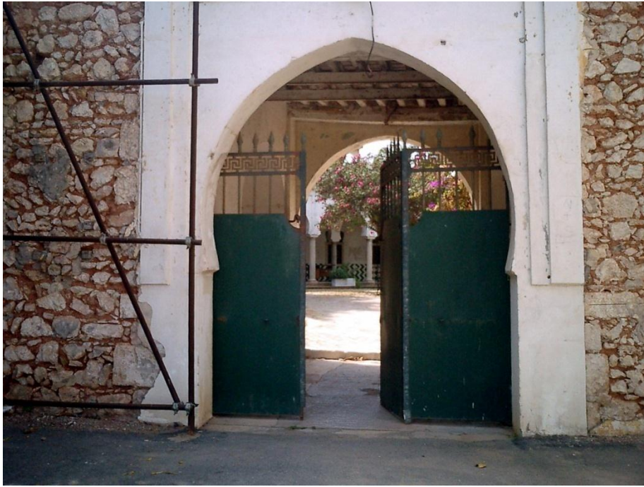
الصورة رقم 15 استعمال الملاط في البناء
