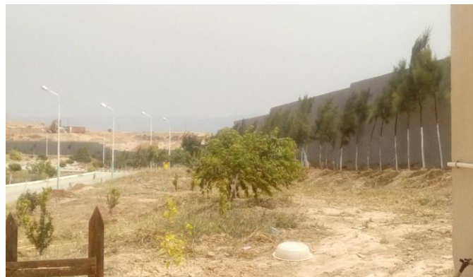
figure 11:le clôture de CET
