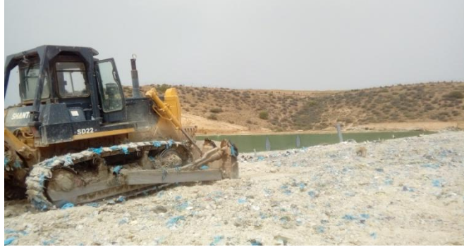
Figure 25: Opération de recouvrement des déchets
