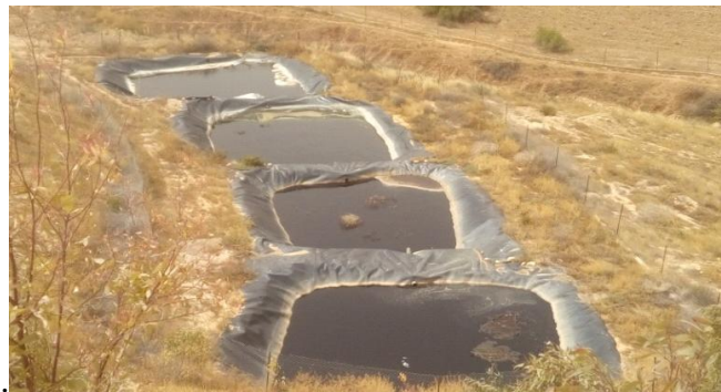
Figure 27: bassins de récupération de lixiviat
