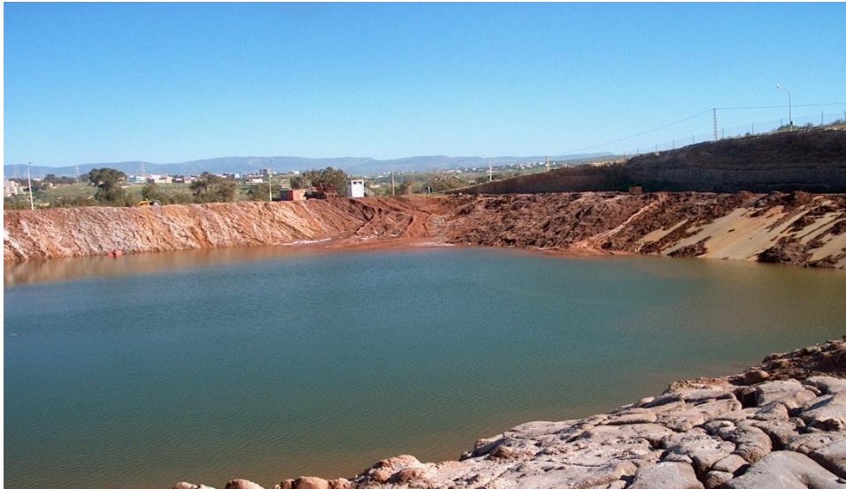
Figure 14 : Bassin de Stockage des résidus
