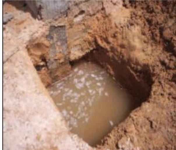
Figure 2 : Niveau de la nappe sous la fondation d'une construction [9]
