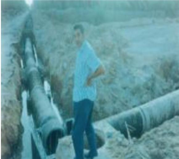
Figure 1 : Niveau de la nappe lors de la pose d'un réseau d'assainissement. d'une conduite en béton [9]
