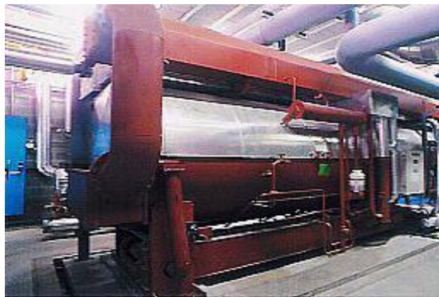
Figure 3.18 : Groupe à absorption d'un hôtel à Benidorm
