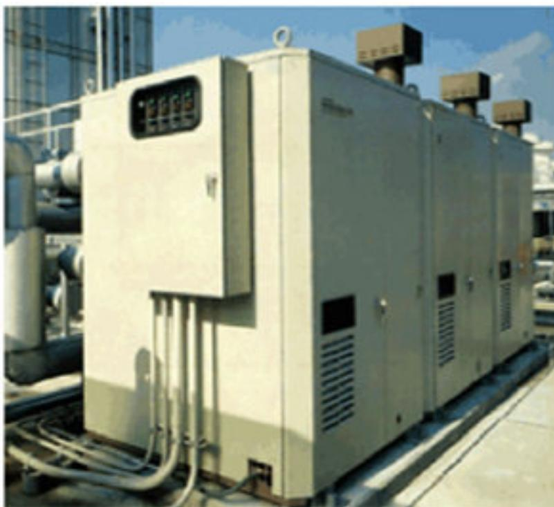
**Figure (I.5.e).** machine à absorption de CH-V(doc .Climgazpro-yazaki)
