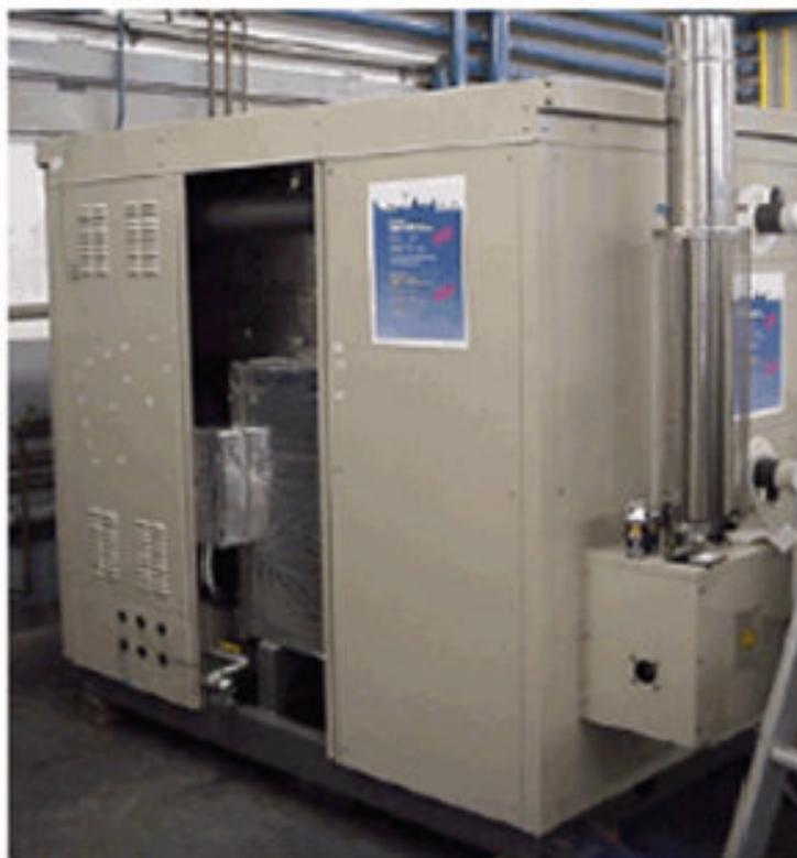
**Figure (I.5 .f).** machine à absorption de type YPMC-F (doc .York-HITACHI)
