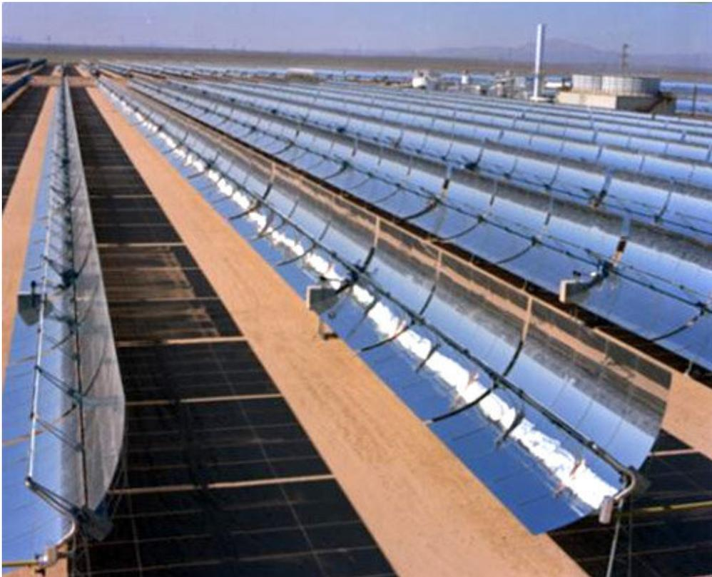
Figure (II.7). Capteur à réflecteur cylindro-parabolique.
