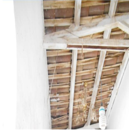
الصورة رقم 09:سقف المجنبة
