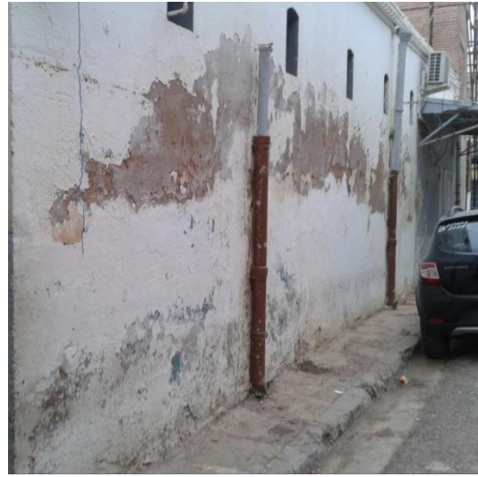
الصورة رقم 03:الواجهة الجنوبية للمسجد
