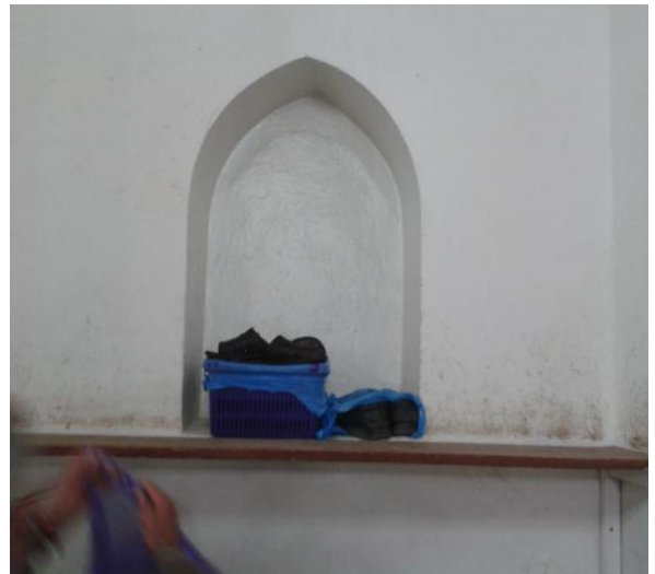
الصورة رقم 33: الكوة الموجودة في الجدار الشمالي لبيت الصلاة
