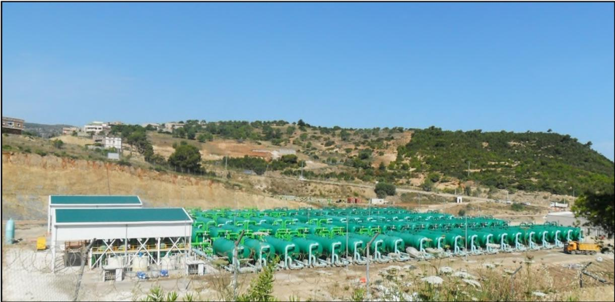
Figure 1.10 Zone de filtration à sable
