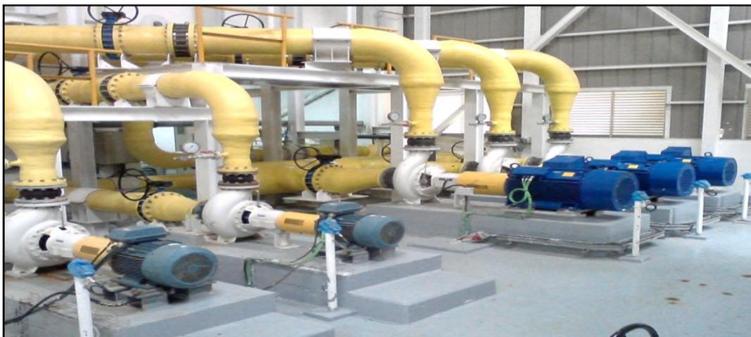
**Figure 1.20** Pompes de nettoyage chimique des membranes
