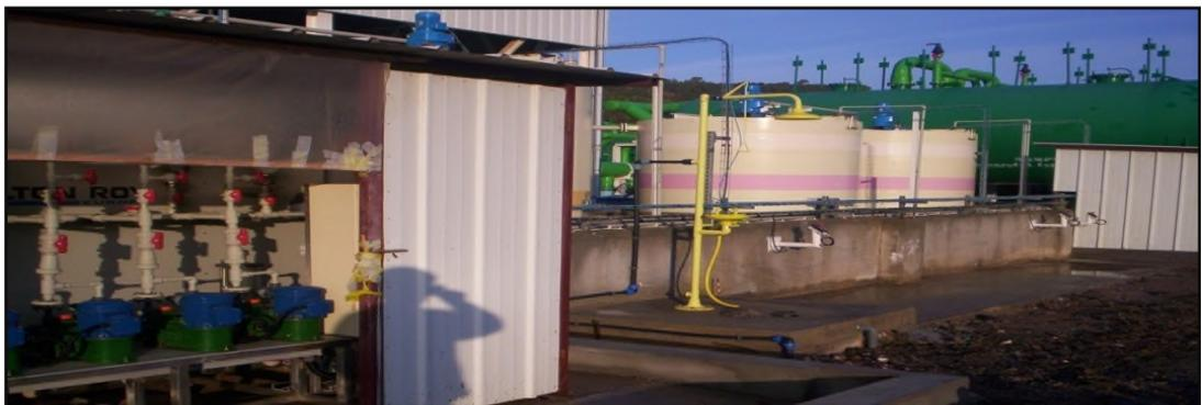
Figure 1.16 Section d'injection de méta bisulfite
