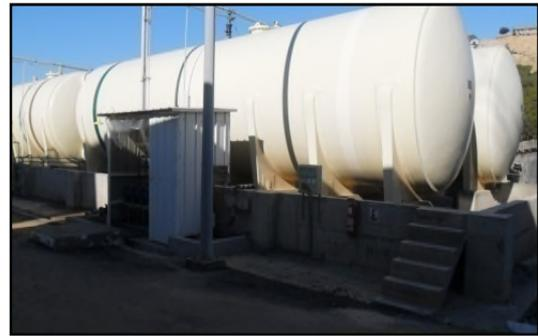
Figure 1.7 Section de dosage d'hypochlorite de sodium (prétraitement)
