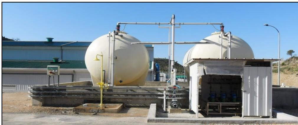
Figure 1.26 Section de dosage d'hypochlorite de sodium (post-traitement)
