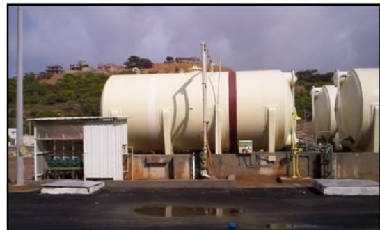
Figure 1.8 Section de dosage de chlorure ferrique
