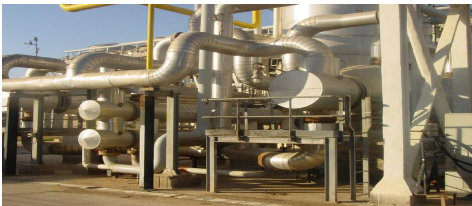
Figure I-2 : Les rebouilleurs
