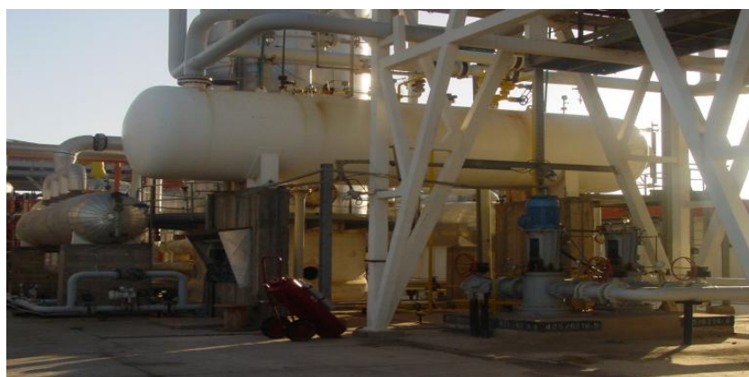
Figure I-3 : Le ballon de reflux
