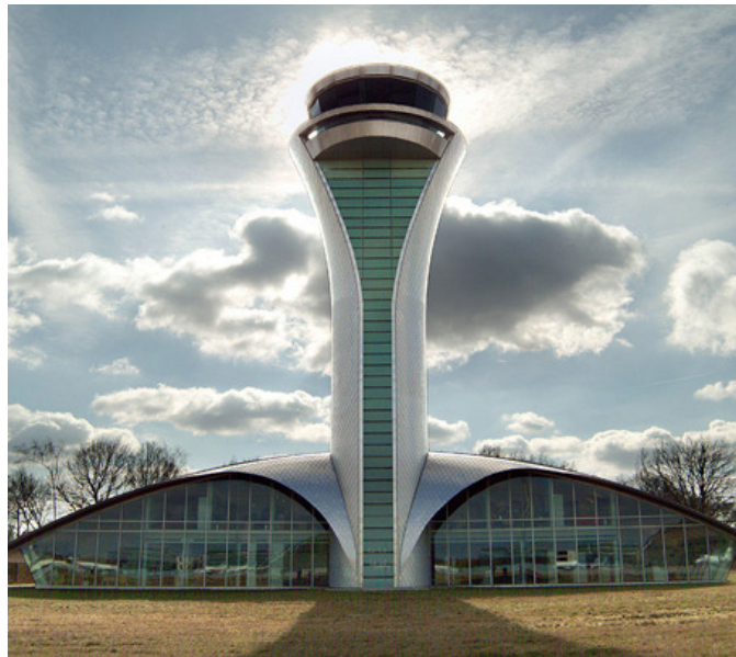
Figure 1.4: Aéroport de Farnborough, aux Royaumes Unies par le Reid Architecture et l'ingénieur Buro Happold.
