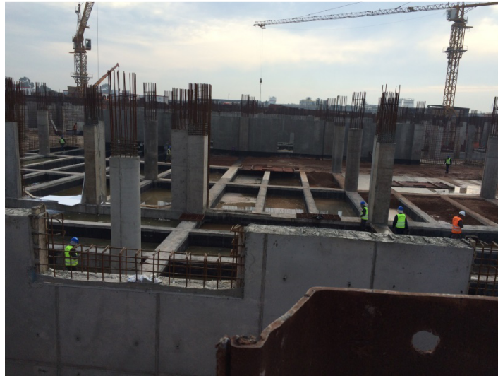
Figure 4.10: Réalisation de la nouvelle aérogare (Janvier 2015)
