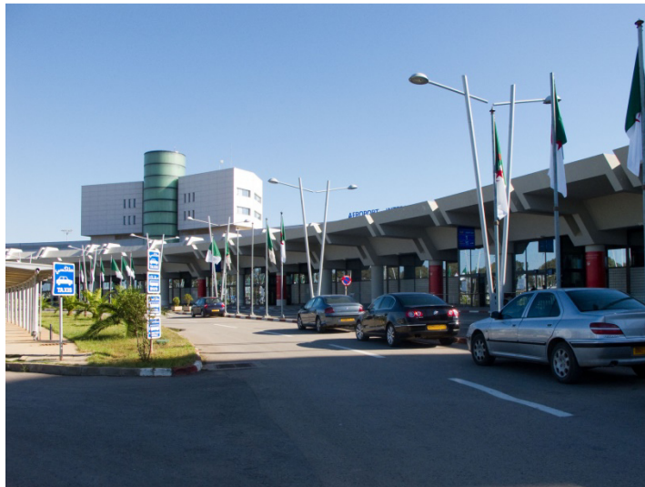
Figure 4.42: Le terminal international de l'AEROPORT D'ALGER - HOUARI BOUMEDIENE-, en Algérie; par Meinhard von Gerkan, 2008.
