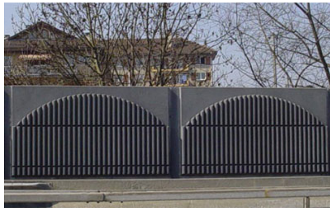
Figure 4.62: Mur anti bruit en béton
