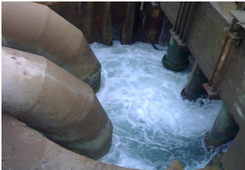
Figure III.7 : Bêche d’aspiration
