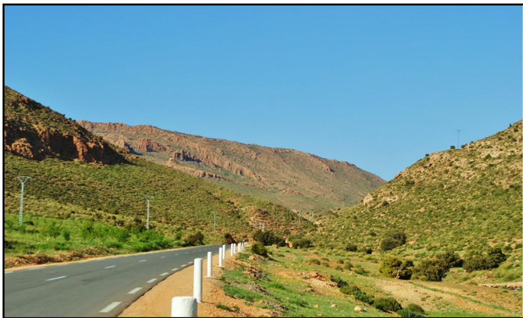
Figure 15 : Vue générale Station étude Sidi Djilali Source : Bedjilali ,2013
