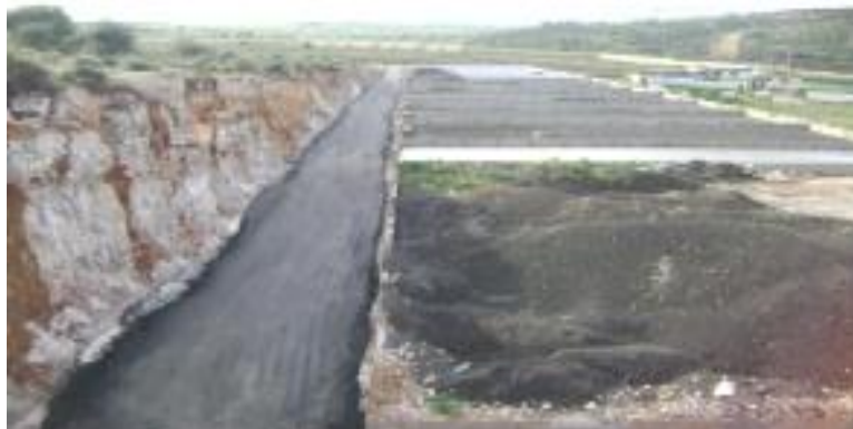
Figure n°7 : Vue d'un lit de séchage rempli de boues (original).
