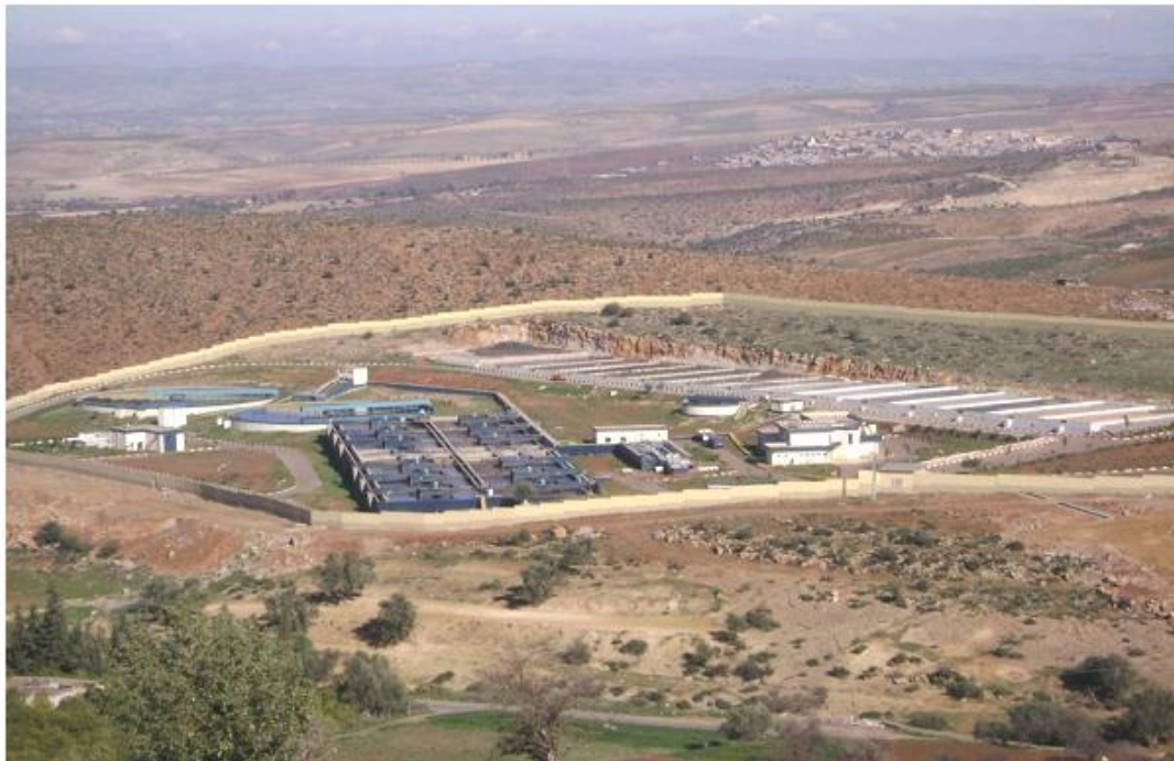
Figure n°1: station d'épuration Ain el houtz (Boumediene M A, 2013).
