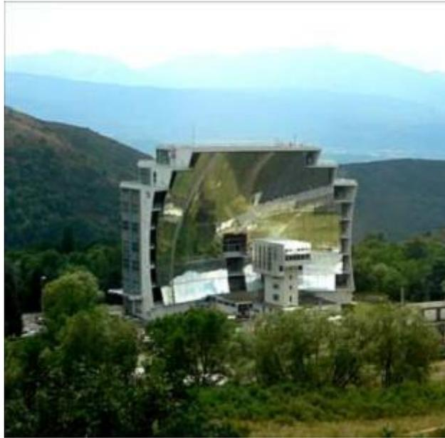
Figure II-10 : capteur à centrale au tour [21].
