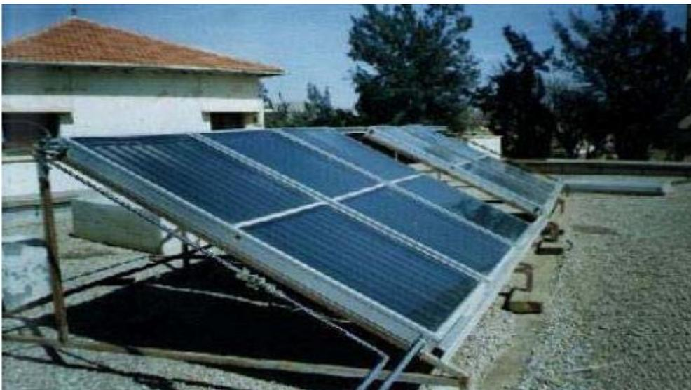
Figure II-8 : capteur solaire vitre [20]
