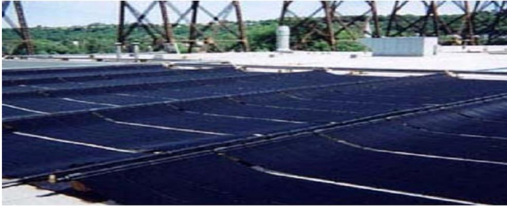
Figure II-11 : Capteurs plans sans vitrage [22].
