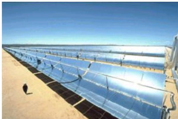
Figure II-9 : Capteur à concentration cylindre-parabolique [21]
