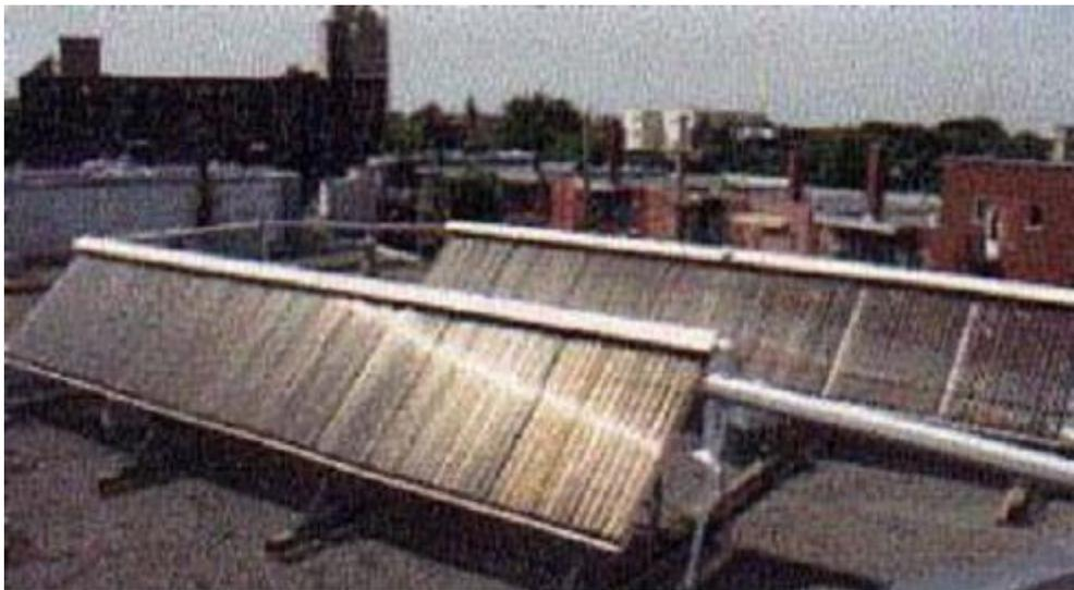
Figure II-12 : capteur sous vide [19].
