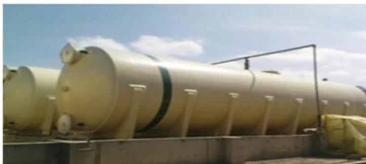
**Figure IV.8:** Les deux réservoirs d'Hypochlorite de sodium.
