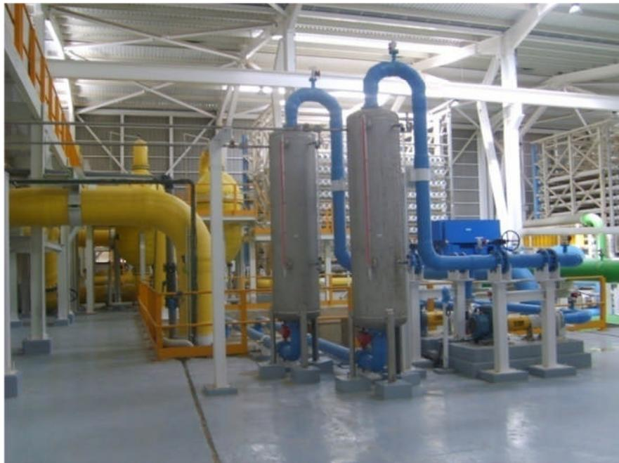
**Figure IV.28:** Système d'injection de CO<sub>2</sub> gaz.
