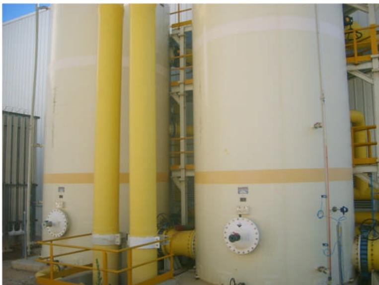
**Figure IV.26:** Réservoir pour le nettoyage chimique.
