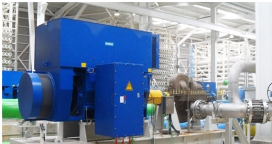
**Figure IV.21:** Pompe à haute pression.
