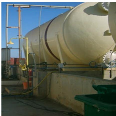
**Figure IV.9:** Réservoirs de chlorure ferrique.
