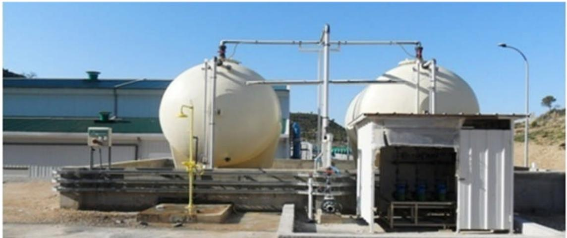
**Figure IV.30:** Réservoir d'Hypochlorite de sodium.
