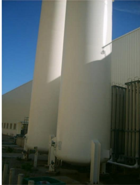
**Figure IV.27:** Les deux Réservoir de CO<sub>2</sub> (liquide).
