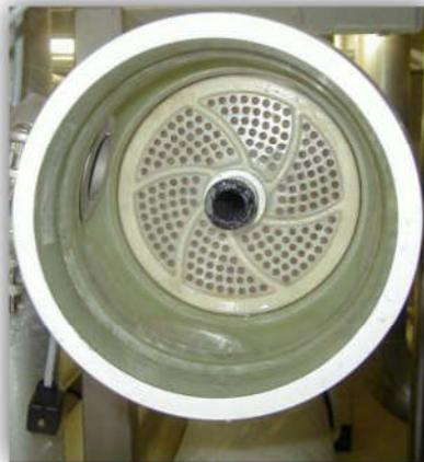
**Figure I.14:** Détail d'un tube a pression.
