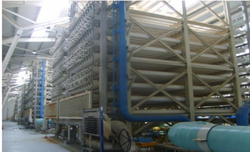
**Figure IV.20:** Châssis a membranes.
