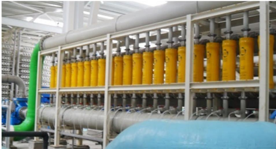
**Figure IV.24:** Installation des échangeurs de pression.
