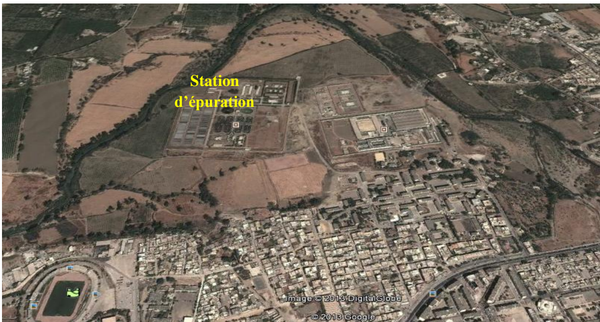
Figure III.1: Carte de localisation de la station d'épuration des eaux usées (STEP) de Chlef (Source: Google Earth. 13/05/2013)
