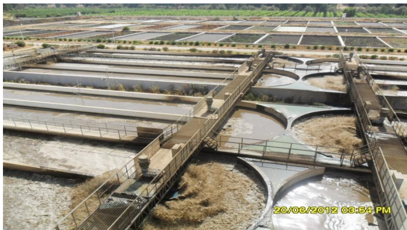
Figure III.5: Bassin d'aération (ONA, 2011)
