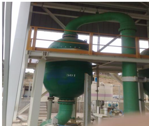
Figure III.10: Photo d'un filtre à cartouche (microfiltration)
