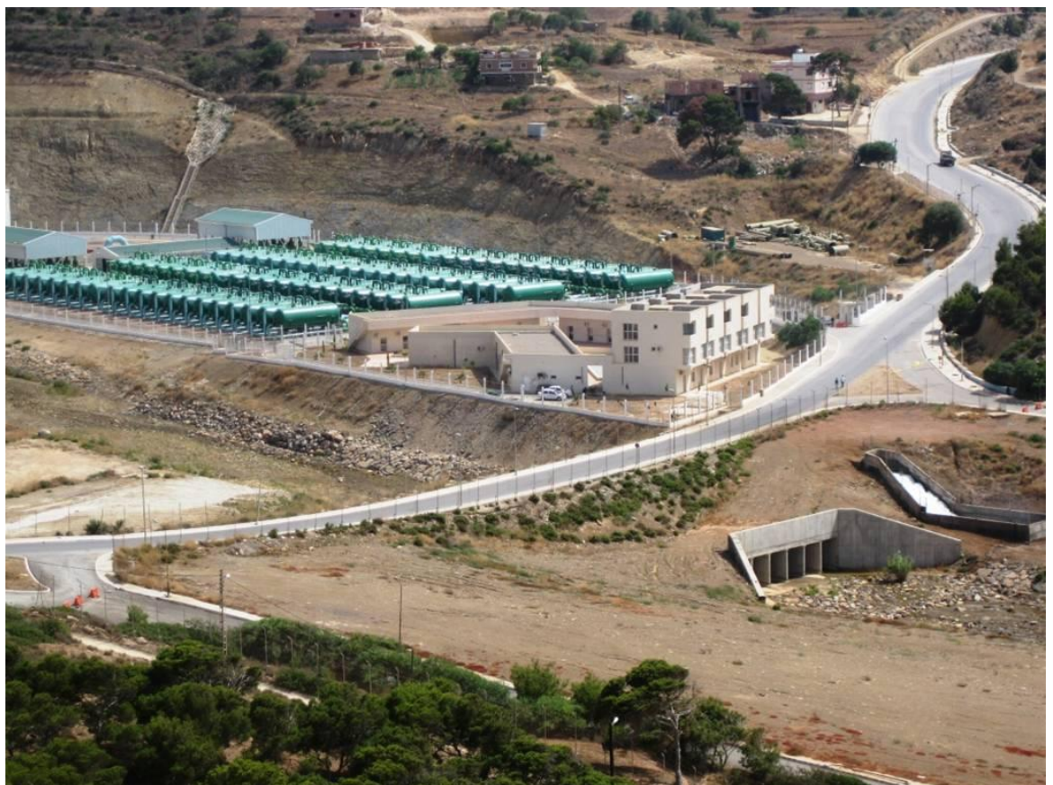
Figure III.1: Photo de la station de dessalement de Honaine
