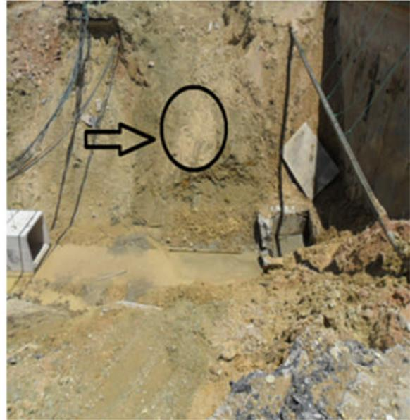
**Photo 3-2 :** la photo représentant la zone après la rupture de la conduite.
