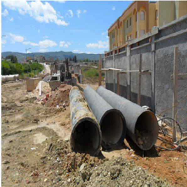
**Photo 3-1 :** La conduite d'adduction de diamètre 800 mm.
