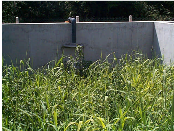
Figure 18: lit de séchage planté de roseaux [92].
