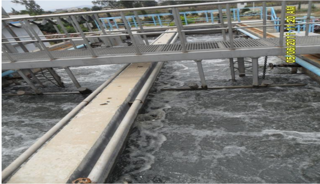
Figure IV.5: Photo du déssableur-déshuileur (ONA.2011).
