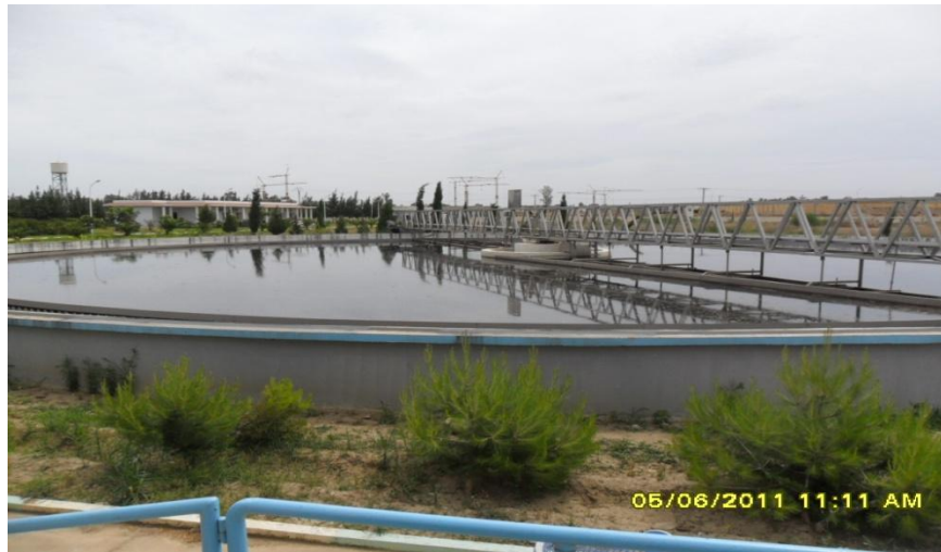
Figure IV.7: Photo du bassin de clarificateur (ONA.2011)
