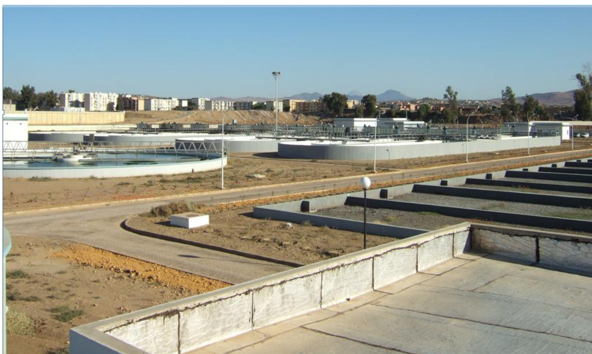
Figure IV.1: Vue de la STEP de Chlef
