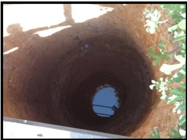
Figure II.7 : Puits non construit.
