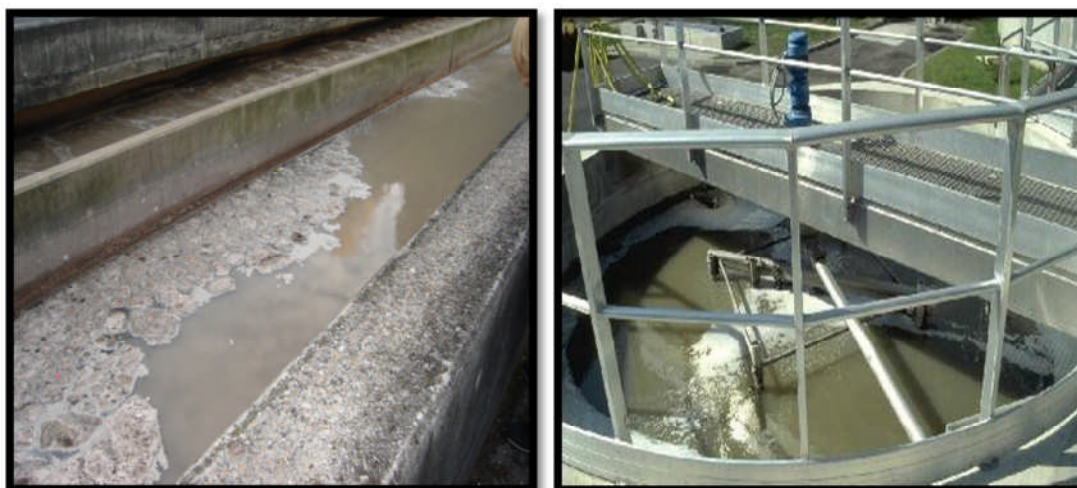
Figure N°04 : bassin de dessablage [27]. Figure N°05 : déshuileur circulaire [27].
