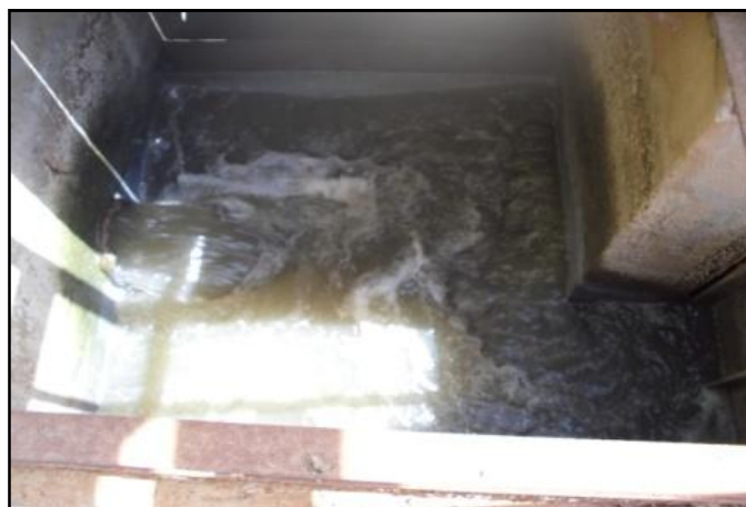
Figure III.4 : Bassin de Stabilisation (22/05/2012)
