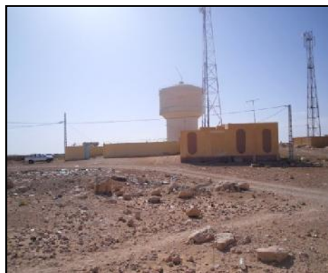
Figure I.5 : Photographie Station de stockage et de distribution d'eau secondaire [ 23/05/2012]
