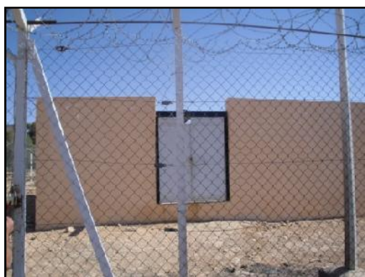
Figure I.5 : station de relevage F2 (KSL) vue extérieur (20/05/2012)
