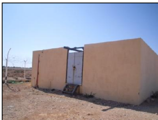
Figure I.3: station de relevage Hay Ezzouhour (F1) vue extérieur (20/05/2012)
