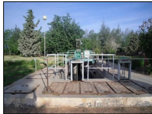
Figure III.6 : Le dessablage-déshuilage (22/05/2012)
