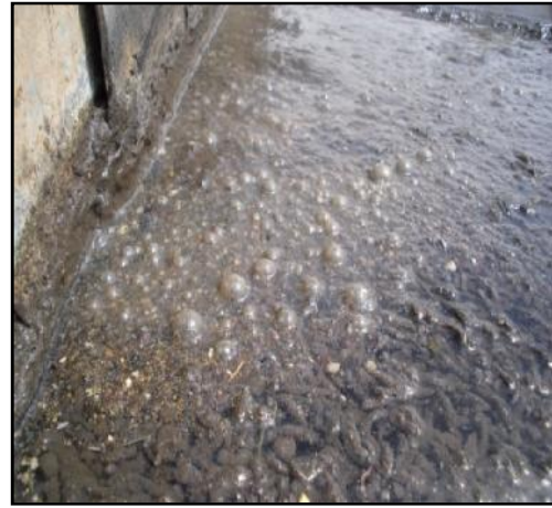
Figure III.10: Boue flottante dans le clarificateur (02/04/2012)
