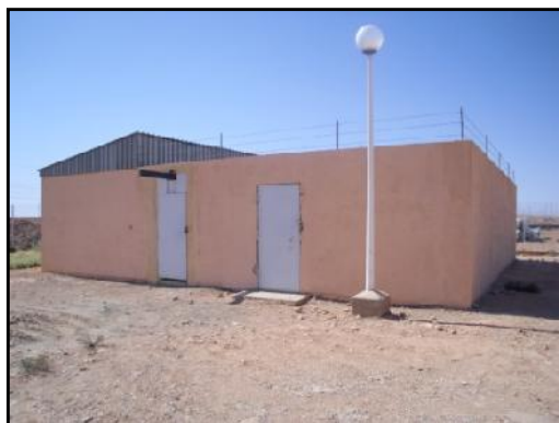
Figure I.7: station de relevage F4 vue extérieur (20/05/2012)
