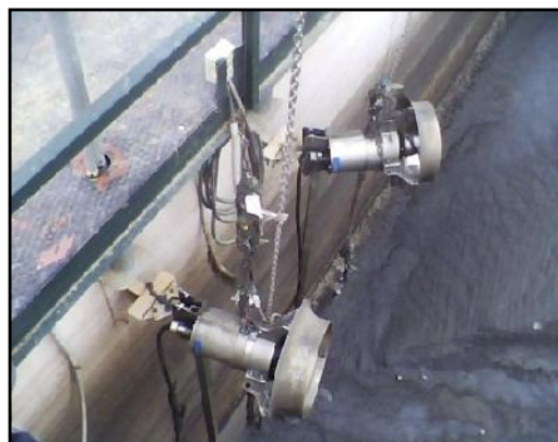
Figure III.3: Bassin de régulation (14/05/2012)
