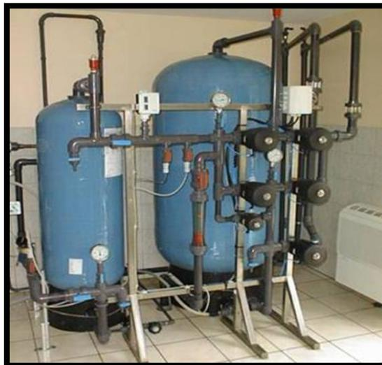
Figure N°12: Déferrisation et démanganisation physico-chimique [66].
