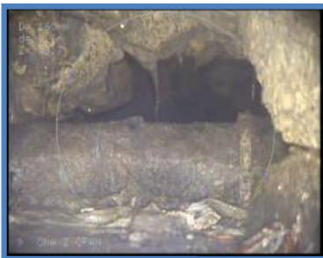
Conduite à l'intérieur d'une conduite
