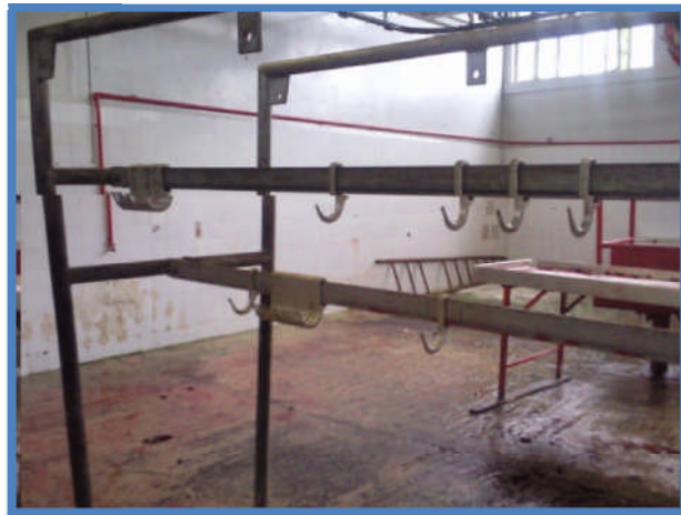
Figure 3.29 : Abattoir de Saf saf (Photo Fellah H.S., 2012).
