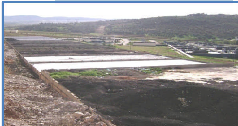
Figure 3.28 : Les lits de séchage et l'aire de stockage (O.N.A, 2010).
