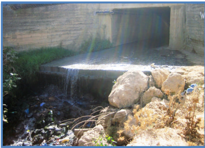
Figure 3.10: Le rejet de nouveau pôle universitaire (Photo Fellah H.S., 2012).
