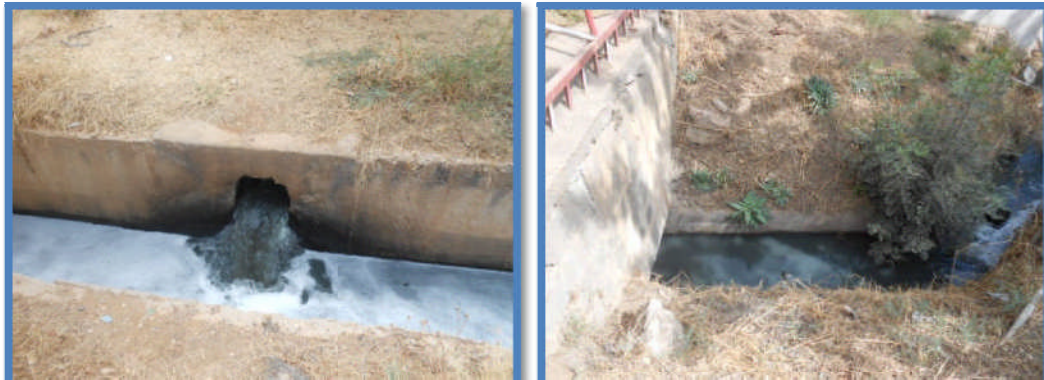
Figure 3.26: Rejet d'unité industriel SOITEX (Photo Fellah H.S., 2012).
