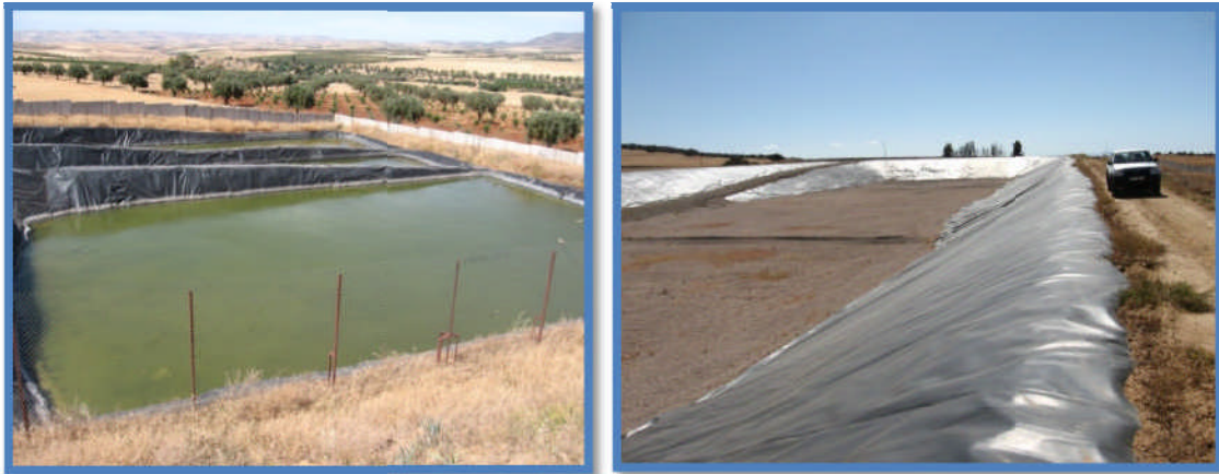
Figure 3.18 : La station de lagunage de CET (Zaoui A., 2007).
